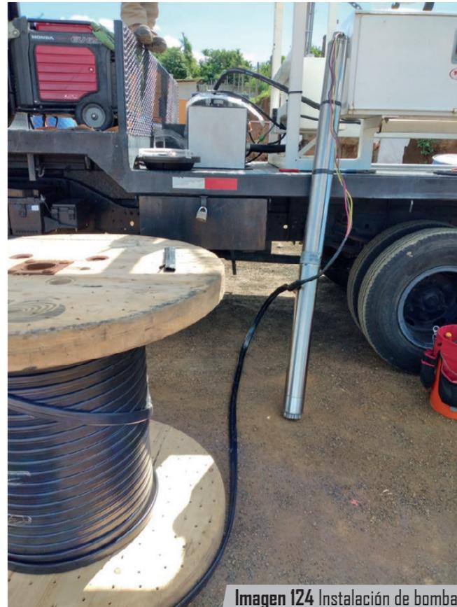
Imagen 124 Instalación de bomba
