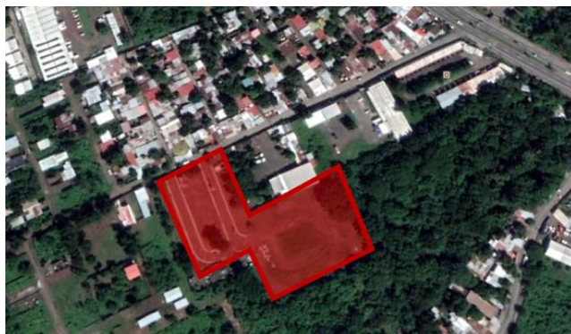
Imagen 4.30: Sitio 3. Ubicado por Km. 9.3 Carretera Nueva a León
