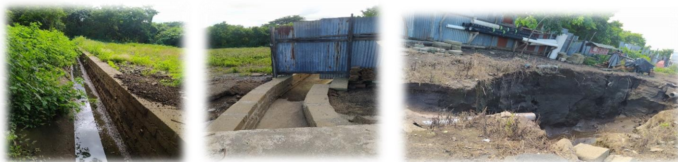
Imagen 4.27: Canales que bordean el terreno y pozo de absorción en construcción
