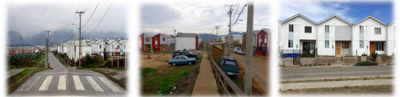
Imagen 3.22: Instalaciones de luz, drenaje pluvial y vialidad Villa Verde Fuente: Proyectos 7
