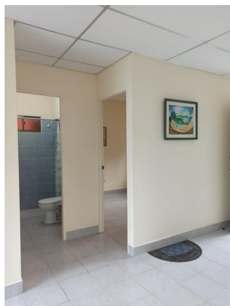
Imagen 3.63: Foto de particiones internas de GYPSUM. Malaquita. Fuente: Tomada por autoras
