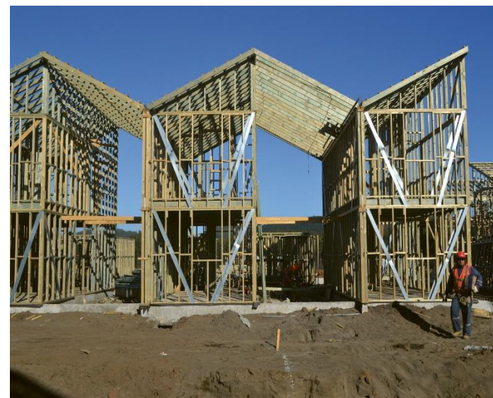
Imagen 3.21: Proceso de construcción de la otra mitad de la vivienda Fuente: Proyectos 7
