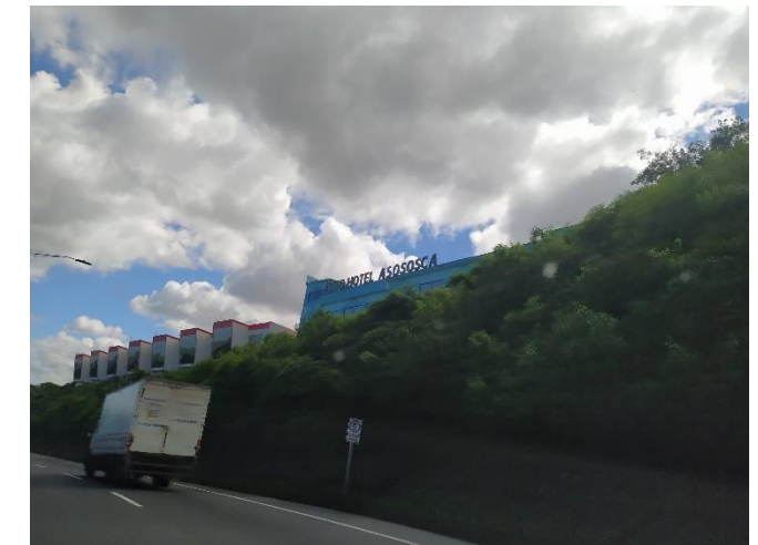
Imagen 4.21: Motel Vista De Asososca Managua. Fuente: Tomador por autoras
