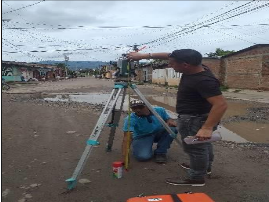
Fotografía 1: Estacionamiento del equipo.
