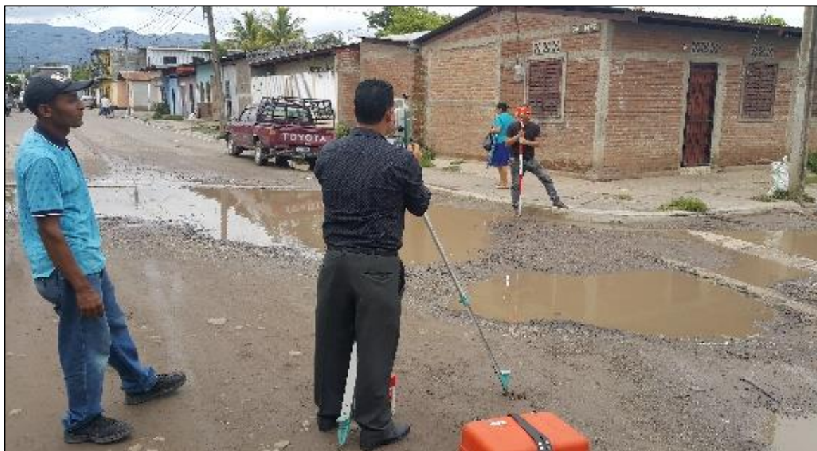
Fotografía 3: Ubicación de puntos de referencia en cuneta existente.
