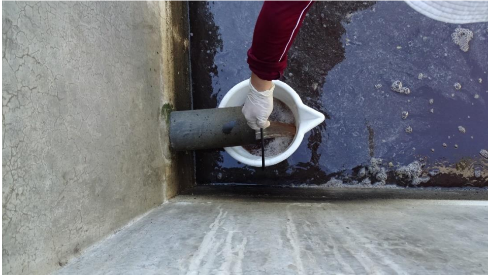
Figura K-3: Medición de caudal en Afluentes
