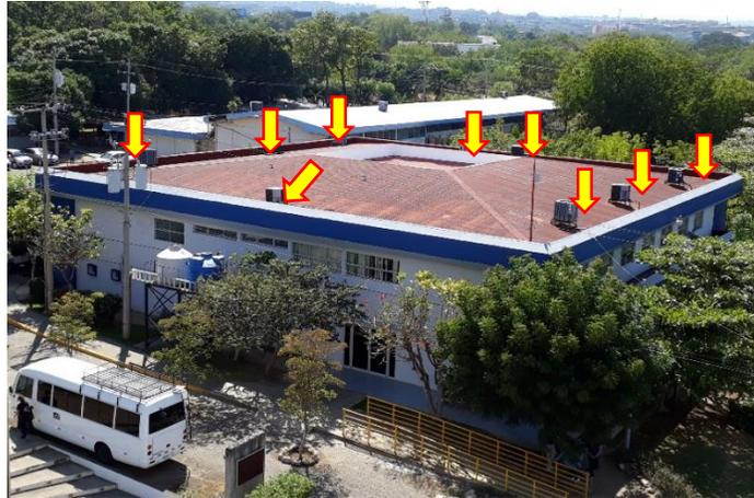
Figura 8.-Fotografía de Ubicación de compresores en el techo del edificio de Posgrado
