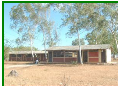
Fachada Principal del Establecimiento Escolar
