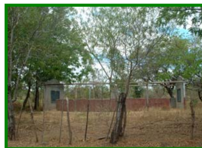
Fachada Principal de Establecimiento Escolar Abandonado
