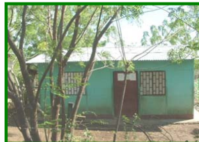
Fachada Principal de Local Escolar.
