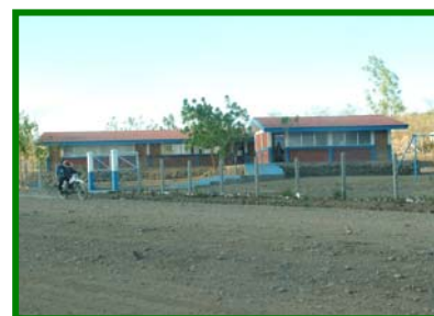
Fachada Principal de Agrupamientos #1 y #2
