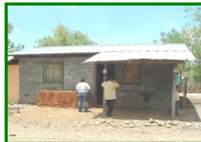
Fachada Principal del Local Escolar
