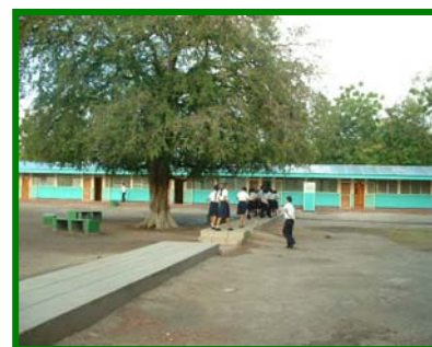
Vista Fachada de Agrupamiento #4
