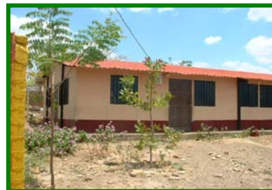
Fachada Principal del Local Escolar
