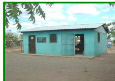
Fachada Principal del Local Escolar
