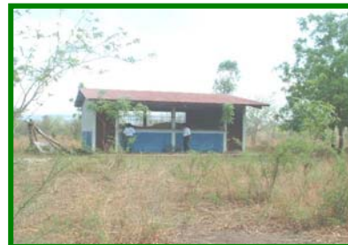
Fachada Principal de Establecimiento Escolar Abandonado
