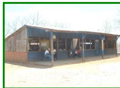
Vista de Fachada Principal
