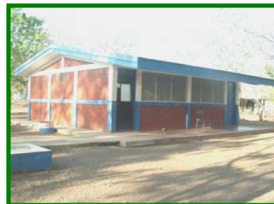
Fachada de Agrupamiento # 1
