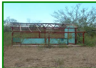
Fachada Principal de Establecimiento Escolar
