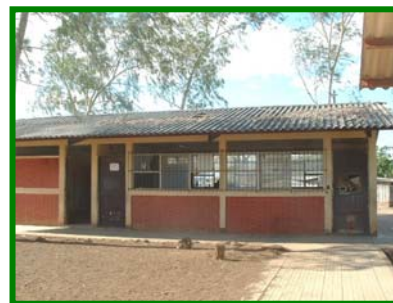
Fachada de Preescolar y Servicios Sanitarios de Escuela Primero de Mayo
