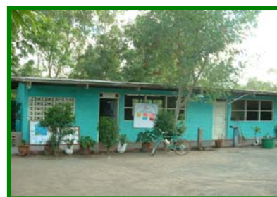
Vista Fachada de Agrupamiento #1
