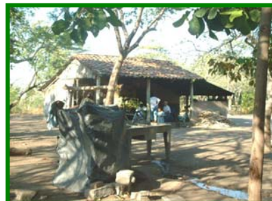
Fachada Principal de Local Escolar.
