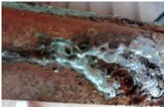
Figura 56 Soldadura realizada con el soldador de Arco DC, fuente propia.
