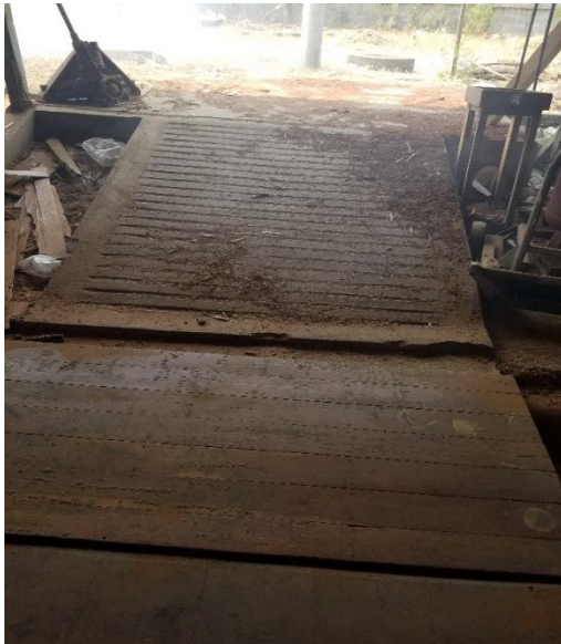
Anexo 27. Rampa de acceso área de pintura.
