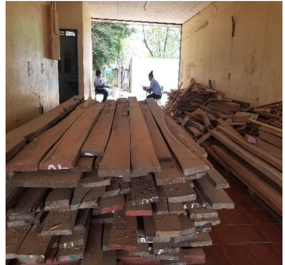
Anexo 34. Pasillo para sanitarios cubierto con renglones de madera
