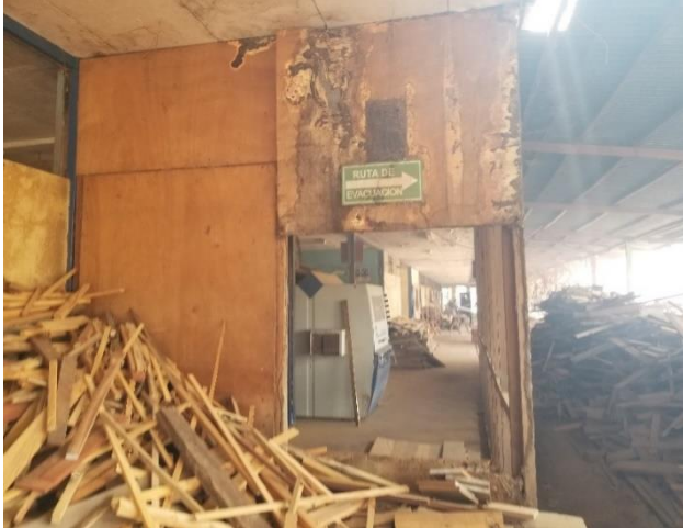
Anexo 25. Pasillo de acceso a descarga de materia de prima.
