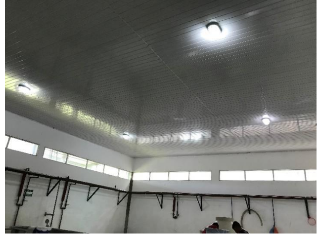
Ilustración 19: Cables colgantes e iluminación con porta lámpara
