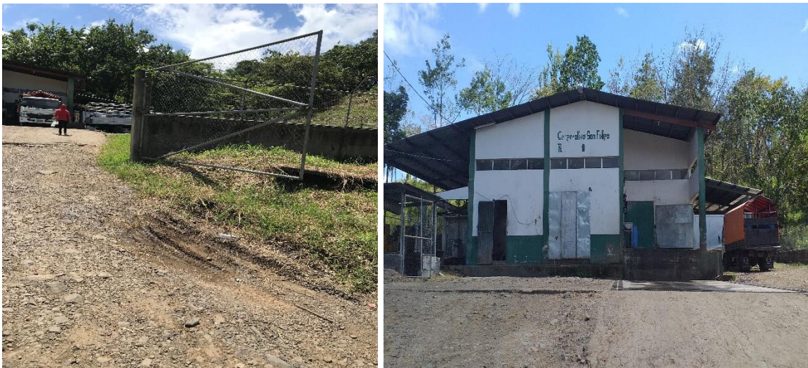
Ilustración 7: Vías de acceso y patios de maniobra no pavimentados
