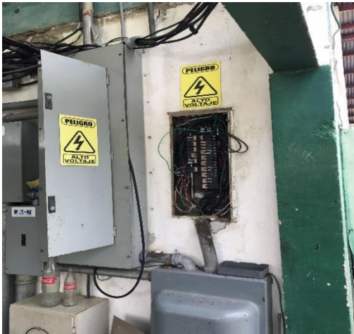
Ilustración 19: Cables colgantes e iluminación con porta lámpara
