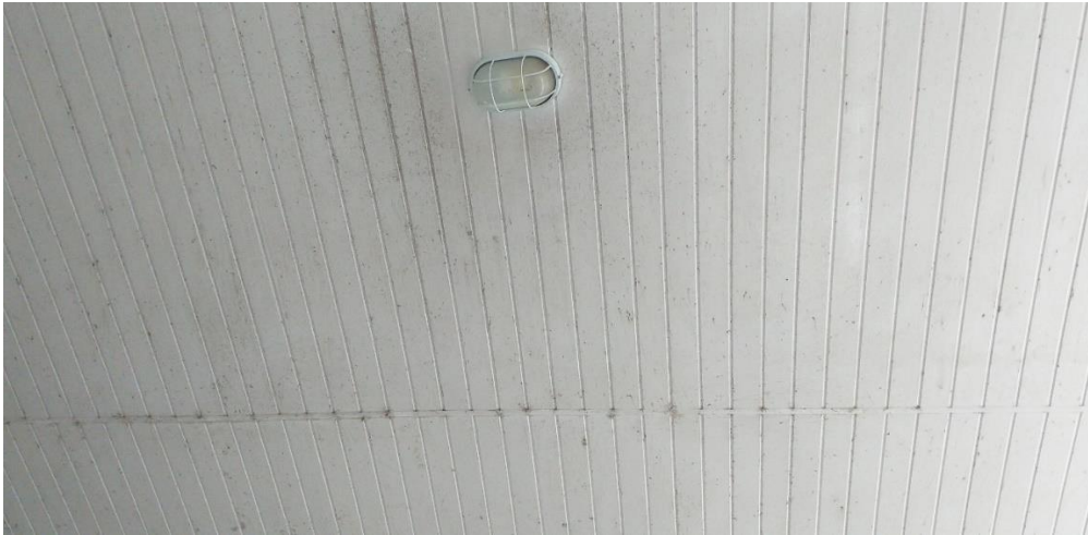
Ilustración 16: Cielo falso con uniones
