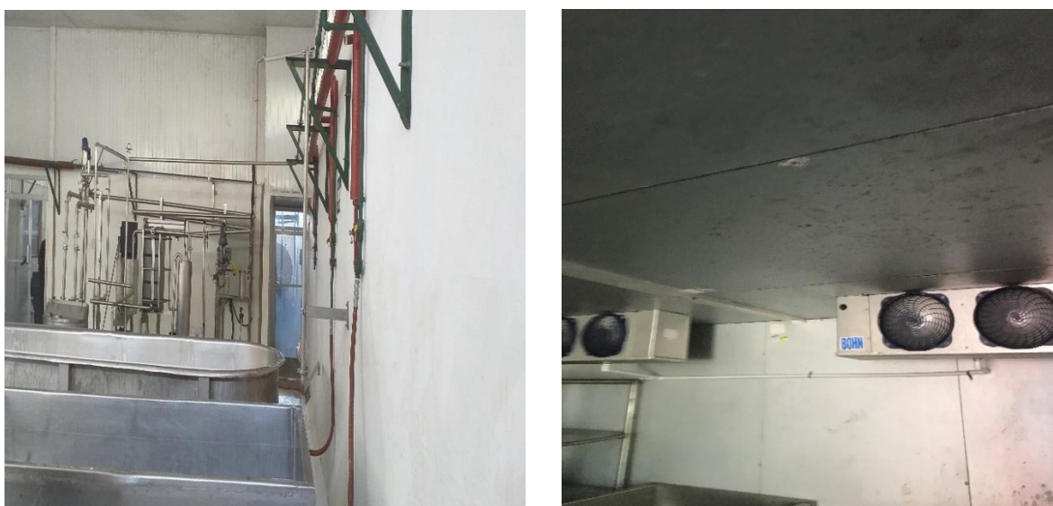
Ilustración 15: Paredes del área de proceso y almacenamiento
