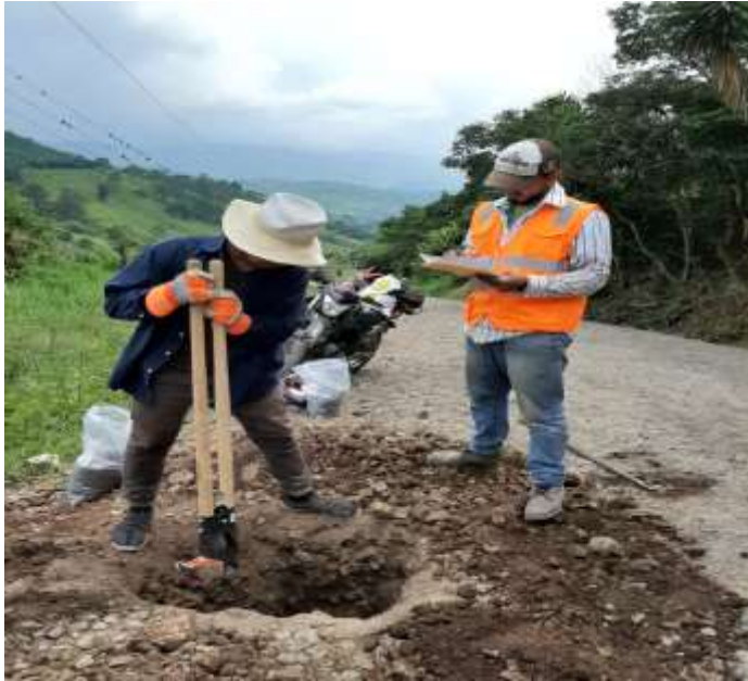
Fotografía 3: Realización de sondeos manuales.
