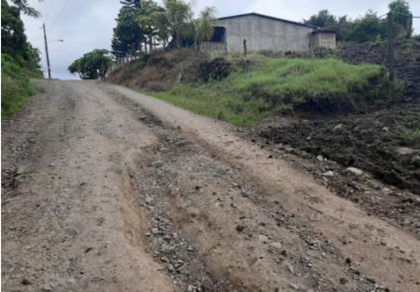
Fotografía 1: Tramo en estudio.
