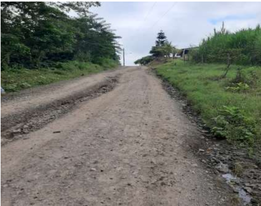
Fotografía 2: Tramo en estudio.
