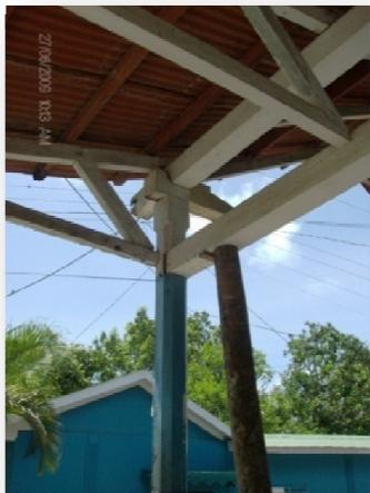
Foto 12 Unión de Viga - Columna
