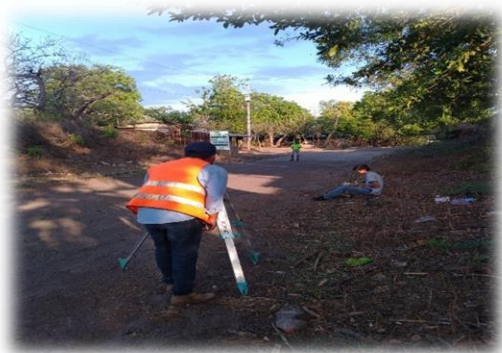
Imagen No. 6. Nivelación topográfica
