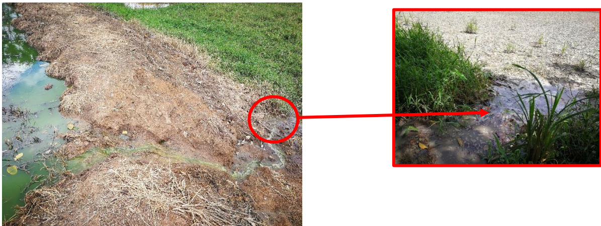
Figura 16. Rebose de efluente de lagunas
