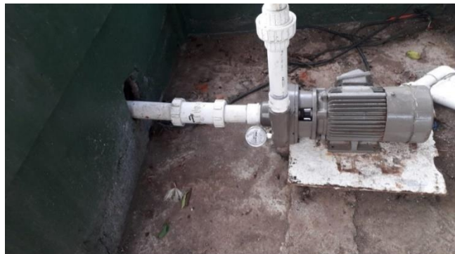
Figura 8. Bomba centrífuga
