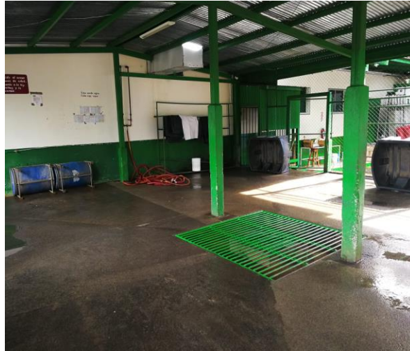
Figura 6. Trampa de desbaste
