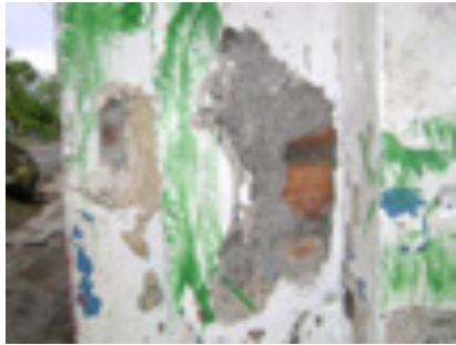
Foto16: sistema de mampuestos- vista sureste. Fuente: Abea, Meza, Zeledón
