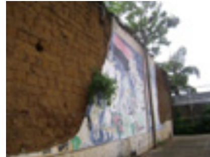
Foto17: sistema constructivo adobe-patio interno. Fuente: Abea, Meza, Zeledón
