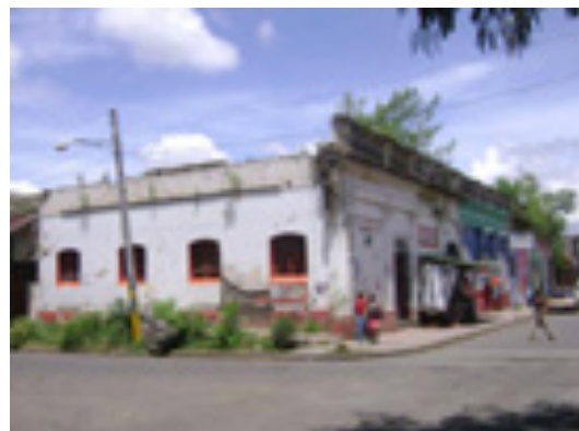
Foto14: galería derrumbada en el año 2000 Fuente: Abea, Meza, Zeledón.
