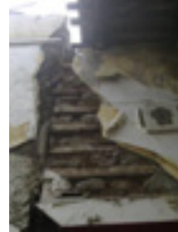
Foto15: sistema constructivo taquezal- vista suroeste. Fuente: Abea, Meza, Zeledón
