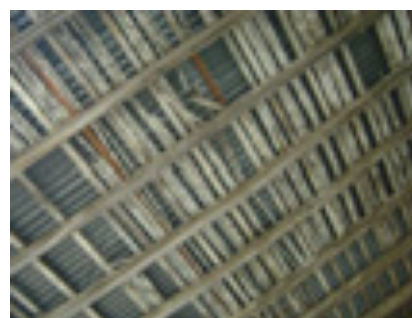
Foto13: Detalle de estructura y cielo raso de caña de castilla, Corredores Fuente: Abea, Meza, Zeledón
