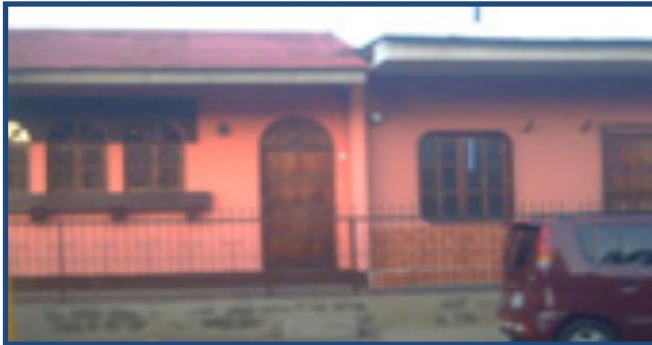
Foto2: casa con fachada contemporánea Fuente: Abea, Meza, Zeledón
