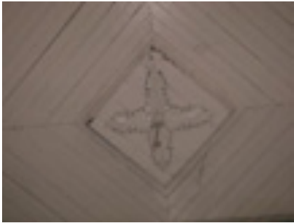
Foto14: Detalle de cielo falso, Cyber Fuente: Abea, Meza, Zeledón
