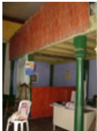
Foto9: Mezzanine de CST Fuente: Abea, Meza, Zeledón.
