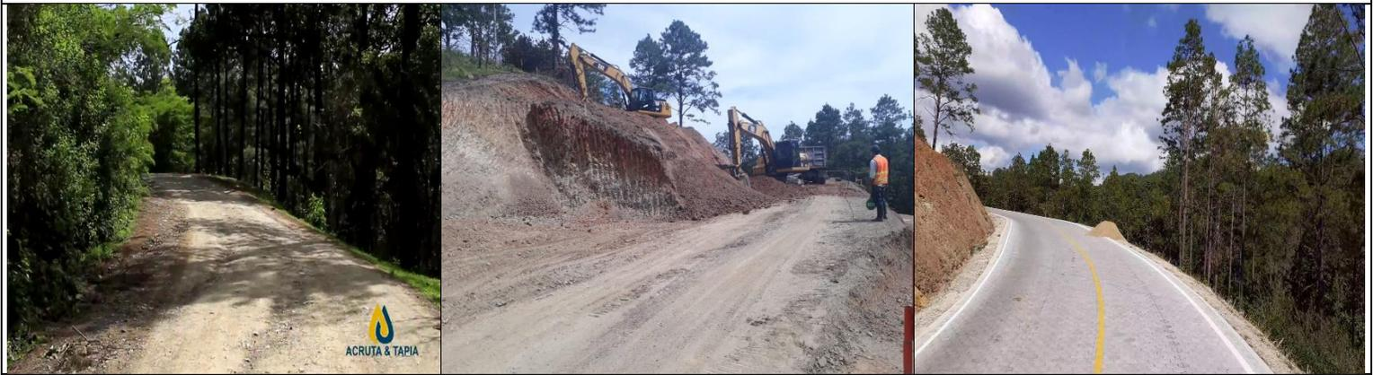
**EXCAVACION EN LA VIA( MATERIAL USANDO EN TERRAPLEN) EN LA ESTACION 4+000 – 4+100**
