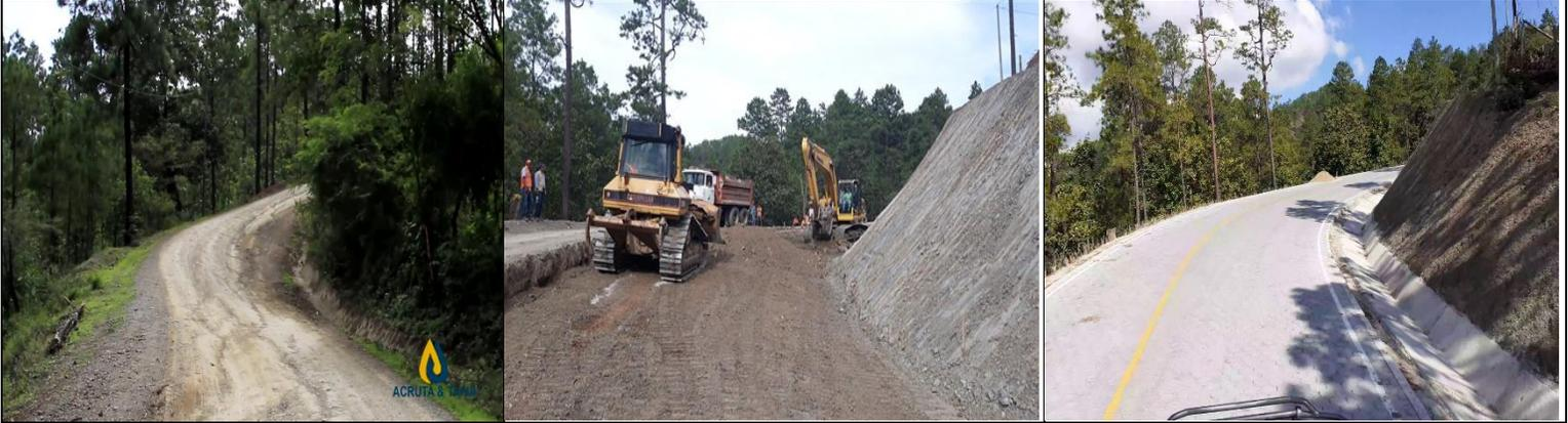
**EXCAVACION EN LA VIA( MATERIAL USANDO EN TERRAPLEN) EN LA ESTACION 5+050 – 5+200**
