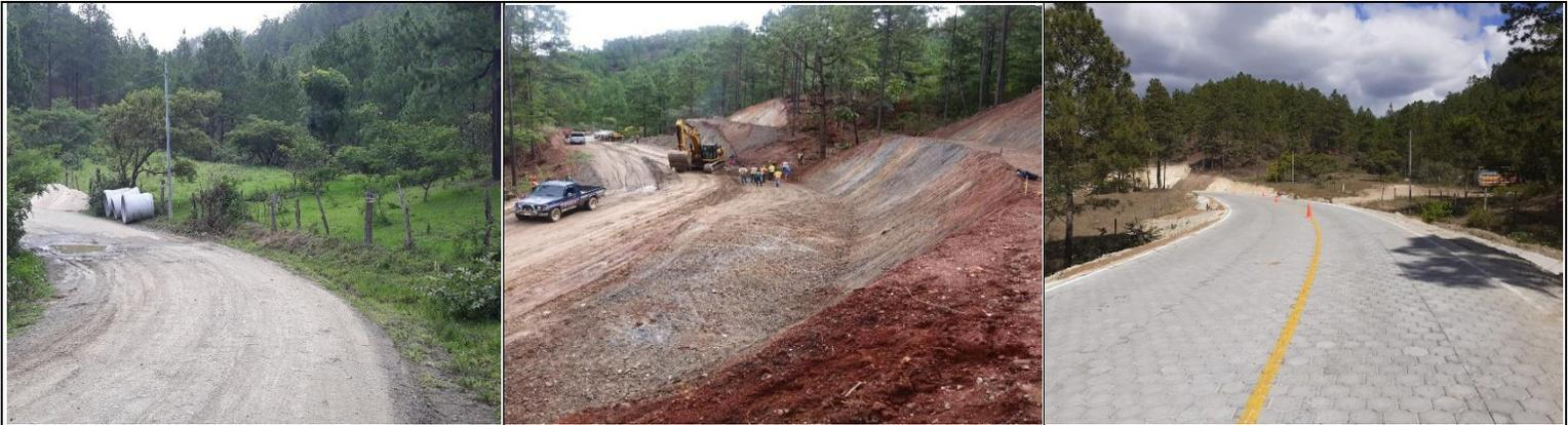
**CONSTRUCCION DE CUNETAS DE CONCRETO DE 2,500PSI EST.6+100 B/D**
