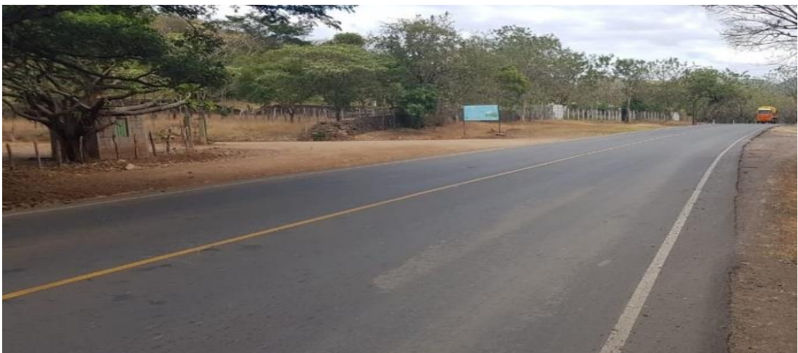
Imagen 40: Falta de paso peatonal, entrada Comarca Posa Larga - km 145
