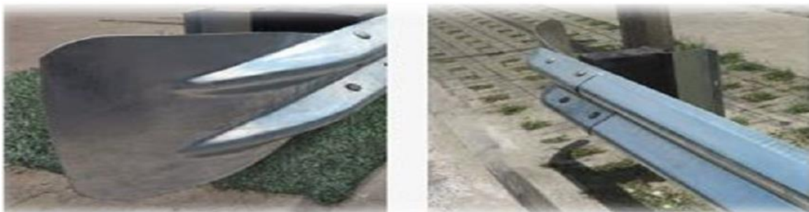
Imagen 13: Terminales de defensas metálicas
