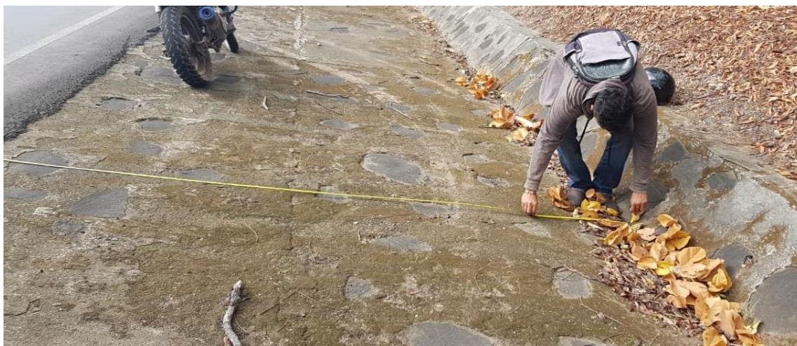
Imagen 12: Comarca Apompua – Estación 150 + 500, toma de medidas del drenaje menor de concreto tipo triangular
