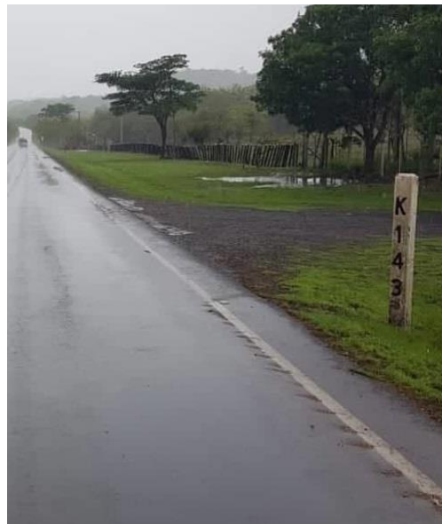
Imagen 26: Salida Juigalpa – Apompuá Estación 143+000 Entrada a Juigalpa
