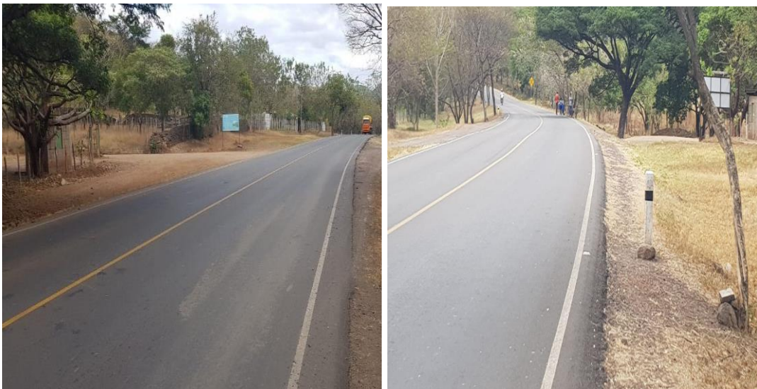
Imagen 42: Falta de flechas direccionales en km 145 entrada a la Comarca Posa Larga Norte – Sur y Sur - Norte
