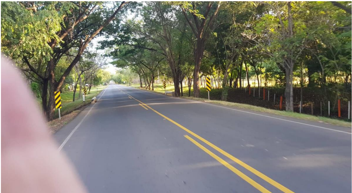
Imagen 39: Líneas de bordes con poco color (Estación 144+500 – Estación145+400)
