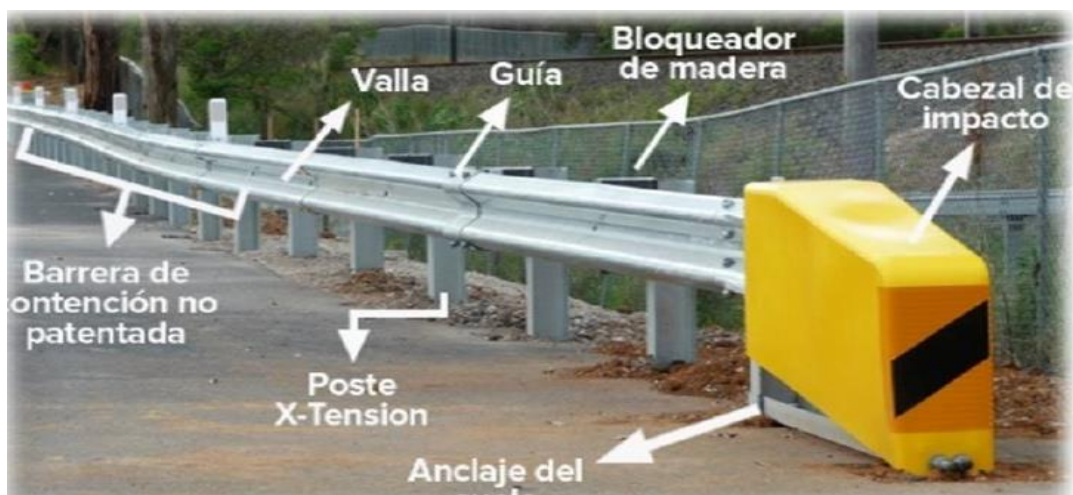
Imagen 16: Partes de las defensas metálicas con amortiguamiento
