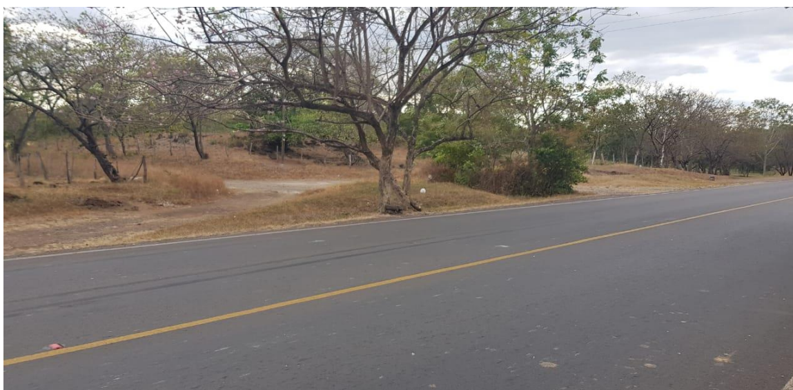
Imagen 44: Falta de ubicación de poste Kilométrico 145
