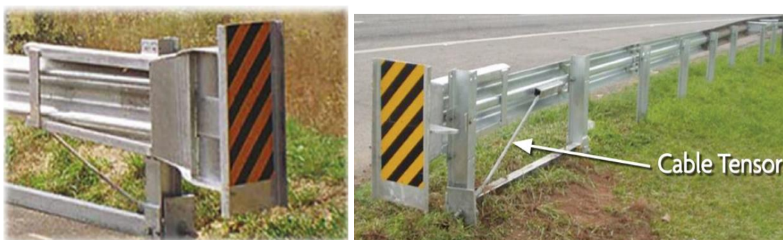
Imagen 15: Defensa con elemento de seguridad en los extremos
