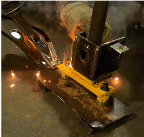
*Figura A.17. Proceso de soldadura entre la base deslizable y la caja del sensor.*
