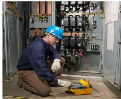
Pruebas de Resistencias de Redes de Tierras para determinar estado del sistema de puesta a tierra (grounding) en los cuartos eléctricos o subestaciones principales, la red de tierra perimetrales y sistema de protección contra rayos:
