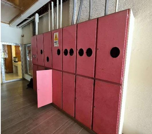
El suministro eléctrico del centro de datos proviene de un panel de distribución donde se alimentan las principales cargas del edificio, contamos con una acometida de 5 líneas (3fases+N+T), calibre de conductores 4AWG, 208/120 VAC con longitud de 30m aproximadamente canalizada en tubería rígida EMT, la capacidad del interruptor principal es de 3x100Amp.
