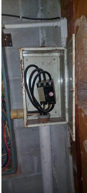
Figura 58. "Protección principal panel I". Fuente: Elaboración Propia.
