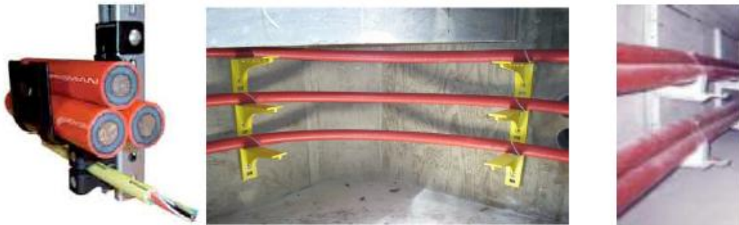
Figura N°27. Soportes para cables
