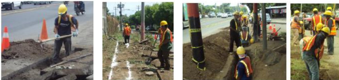
Figura N°30. Apertura de zanja y compactación.
