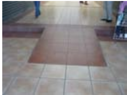
Fotografía 9. Rampas. Fuente: Autora 2010.
