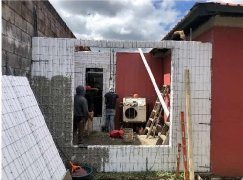
Imagen 99. Instalación de paredes PCH, área nueva de oficina / FUENTE: Autor.
