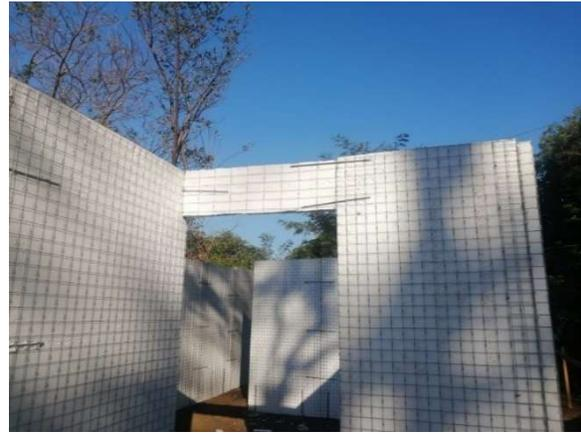
*Imagen 83. Instalación de paneles covintec.
