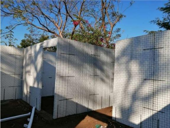
*Imagen 82. Instalación de paneles covintec.
