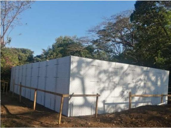
*Imagen 84. Instalación de paneles covintec, niveletas
