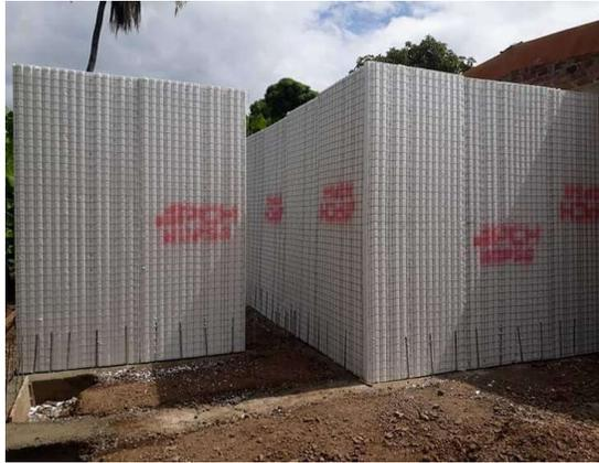
Imagen 74. Colocación de paneles Covintec
