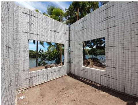
Imagen 118. Corte de boquetes e instalación de accesorios / FUENTE: Autor.
