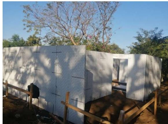
*Imagen 85. Instalación de paneles covintec.
