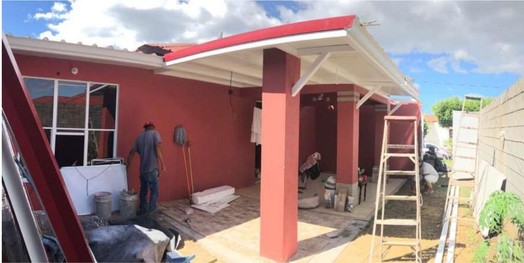
Imagen 98. Instalación de termopanel en terraza
