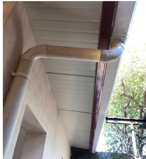
*Imagen 113. Techo de termopanel, alero.
