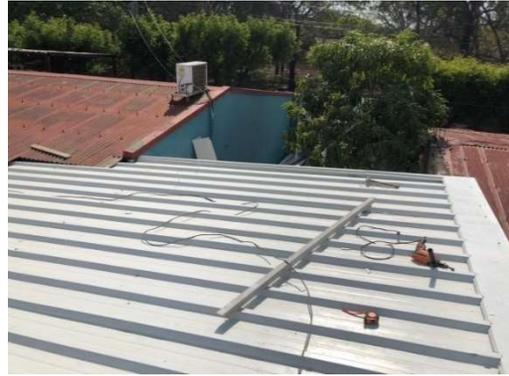
*Imagen 111. Cubierta de techo termopanel
