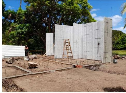
Imagen 117. Colocación de paneles PCH
