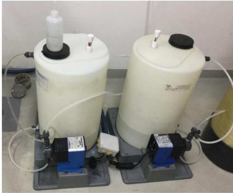
Figura 56: Bombas dosificadoras de soda caustica y anti Escalante
