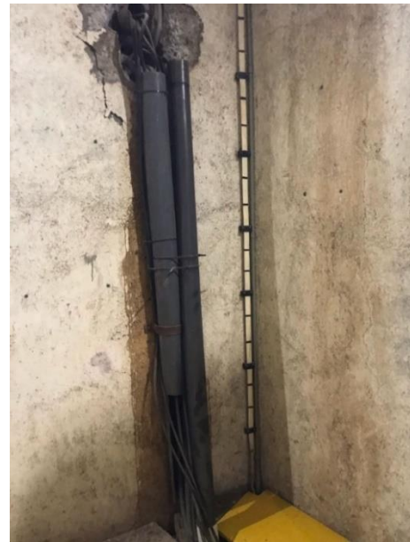
Ilustración 4 acometida mal elaborada
