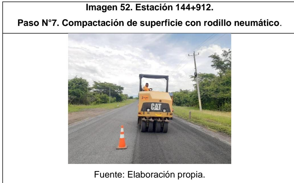
Las ruedas delanteras y traseras deben estar espaciadas de manera que el espacio entre las llantas adyacentes sea cubierto por la huella de la siguiente llanta. Luego de compactar la superficie, es normal que algunos agregados queden sueltos.
