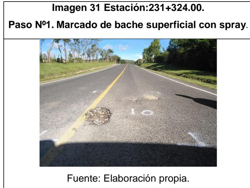
El área debe ser marcada por el supervisor, debiendo ser dos de sus lados perpendiculares al eje del camino. Los cortes de las paredes deben quedar parejos y verticales.
