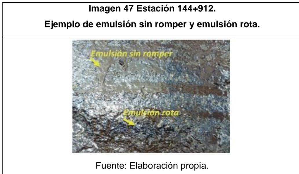
Para este tipo de riegos se utilizan ligantes muy fluidos de rompimiento, siendo recomendables los diseñados específicamente para tal fin. De esta forma, el ligante penetra ligeramente por propiedad de capilaridad en la capa granular, adecuando la superficie de apoyo del pavimento y contribuyendo a atenazar las capas afectadas.
