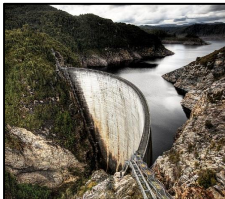
Ilustración 4: Presa bóveda (Presa Gordon. Tasmania, Australia).
