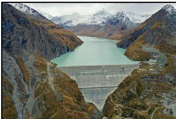
Ilustración 3: Presa de gravedad (Presa Grande Dixence. Cantón de Valais, Suiza).
