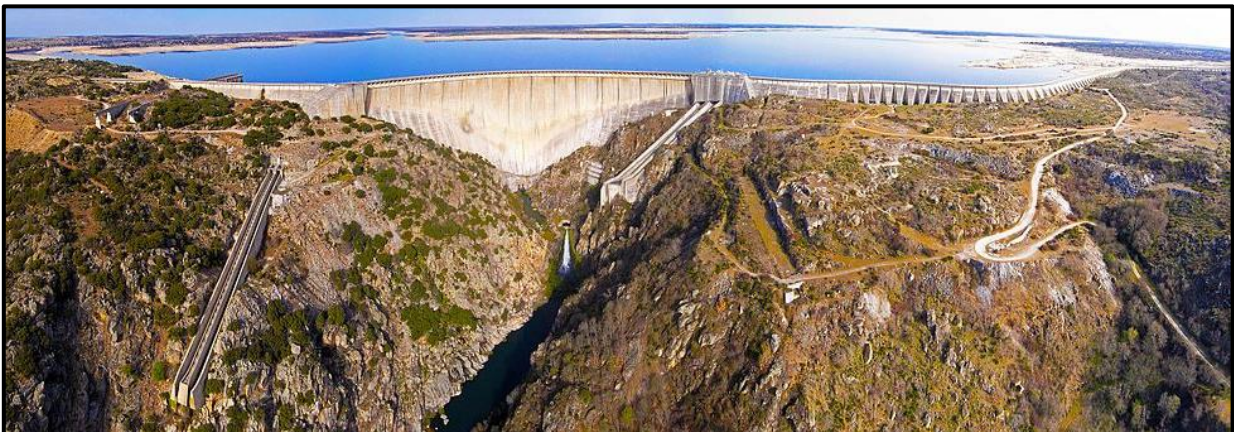
Ilustración 7: Presa combinada (Presa de Almendra. Castilla y León, España).
