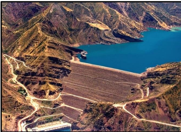
Ilustración 1: Presa de tierra (Presa de Nurek. Tayikistán).
