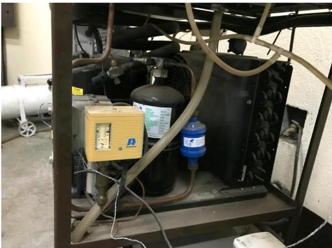
**Figura N°13:** Receptor de líquido.
