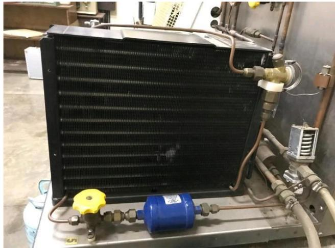
**Figura N°7:** Condensador enfriado por aire.
