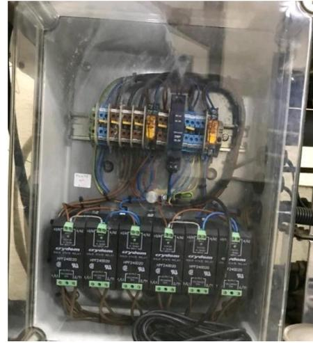
Figura N°9: Contactores de energía.
