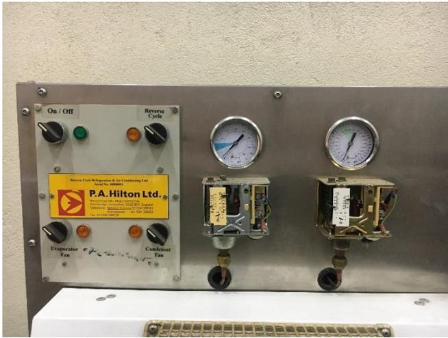
**Figura N°5:** Conmutador LP y Conmutador HP.
