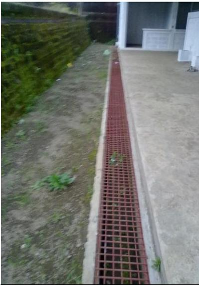
**Elemento de drenaje rejilla sobre en bordillos de edificio**
