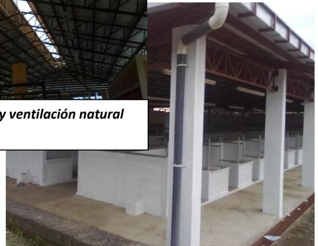
**Elemento de drenaje de agua pluviales canales**
