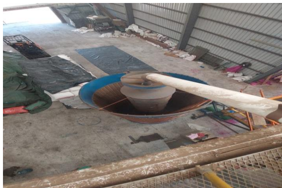
Figura 18. Vista superficial de la secadora de columna
