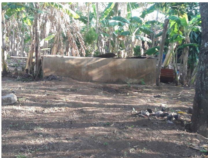
Foto N° 4. Pila de almacenamiento de agua potable
