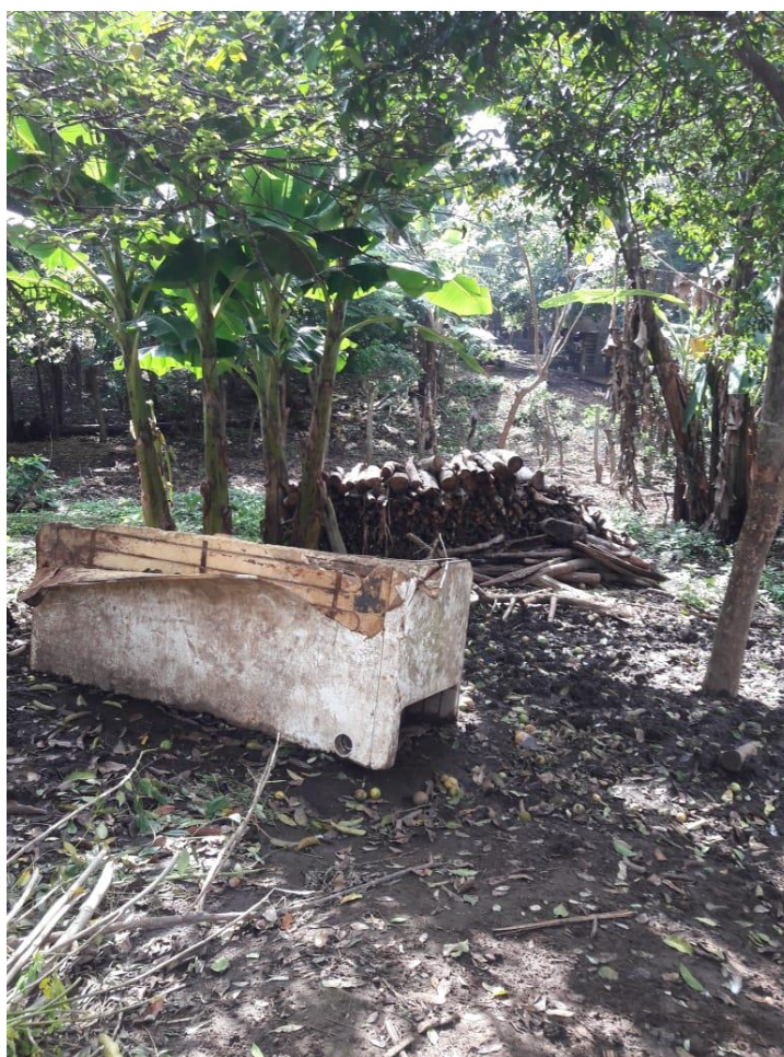
Figura N o 12. Pila para almacenamiento de agua en estado deteriorado en finca propiedad de Alfonso López
