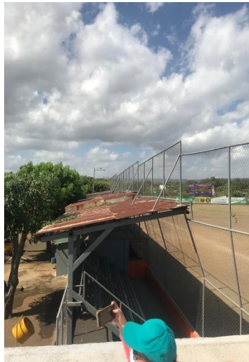
Vista lateral izquierda, Gradería. Fuente: Propia.
