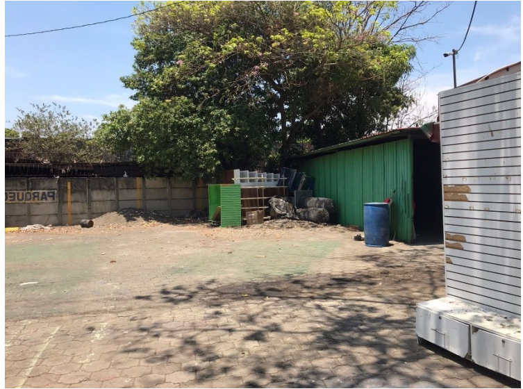
Imagen. Vista trasera, ubicación proyectada para Cocina del Rancho-bar. Fuente: Propia.
