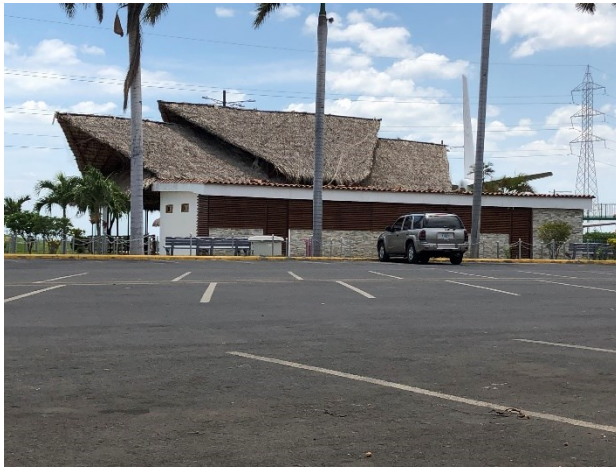
Imagen. Fachada principal, rancho Salvador Allende Fuente: Fotografía tomada por Arq. Rita Halleslevens.
