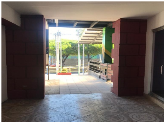
Imagen. Acceso a terraza y modulo 2.
