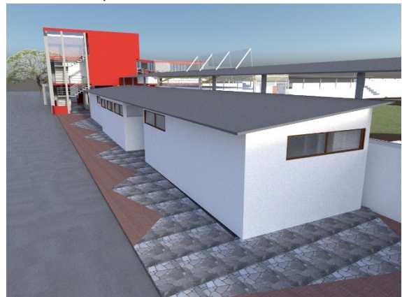
Imagen. Servicio Sanitario lateral derecho. Fuente: Propia.
