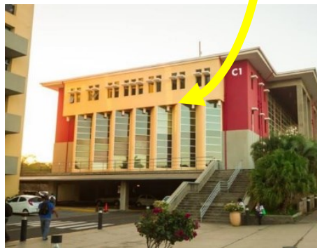
Imagen 01: edificio el centro La empresa ubicada en el primer nivel
