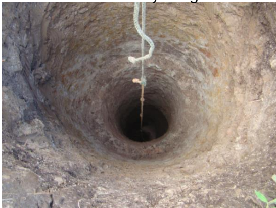
Figura No 17 Pozo en construcción Cercano al río Ventura, 12 m de Profundidad y sin gua
