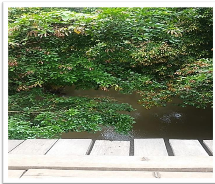
Vista aguas abajo sobre el puente en rio Ventura.
