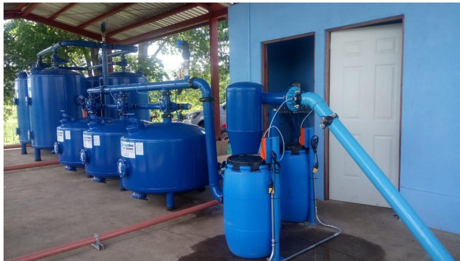
Figura No 7 Filtros presurizados compacta
