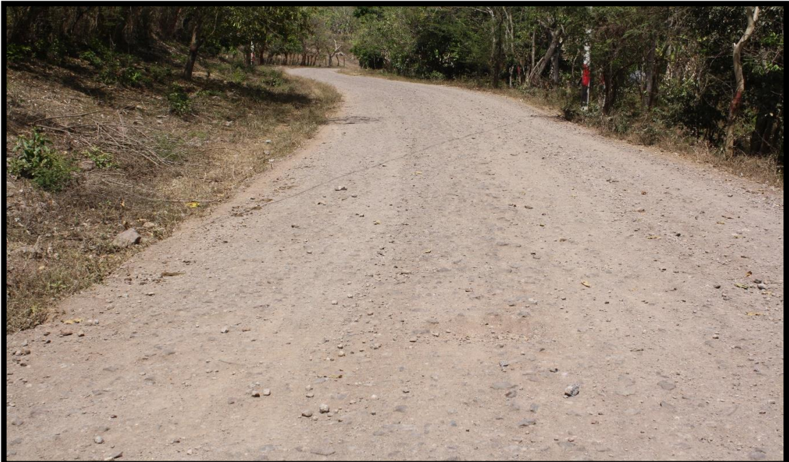
Foto 4: Estación 0+640, Desgaste Moderado de la superficie de Rodamiento.
