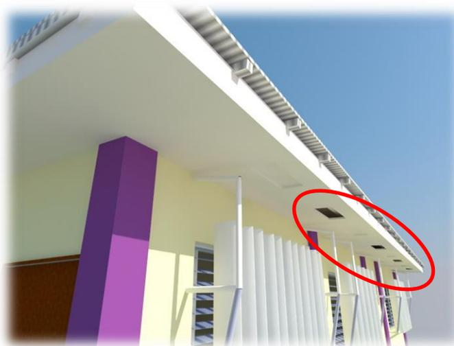
Figura No. 56. Rejilla de ventilación del techo ventilado. Fuente: Propia.
