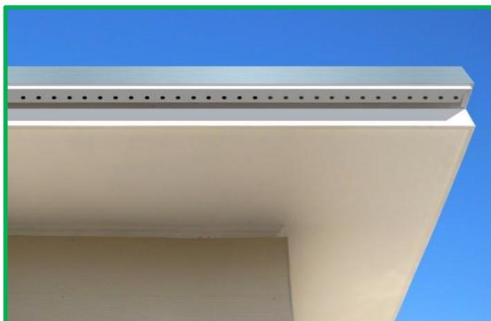
Figura No.12. Cámara de aire exterior con aislante continua. Fuente: Universidad Católica de Chile.
