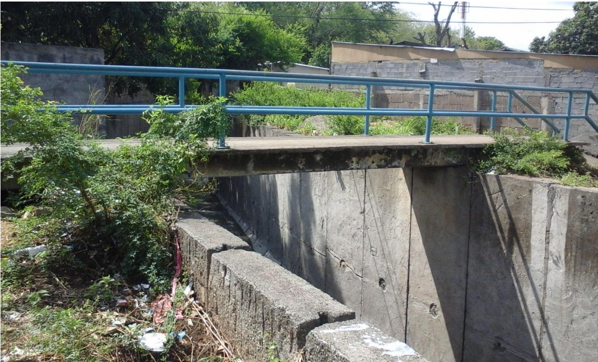
Foto 1 Puente Peatonal existente
