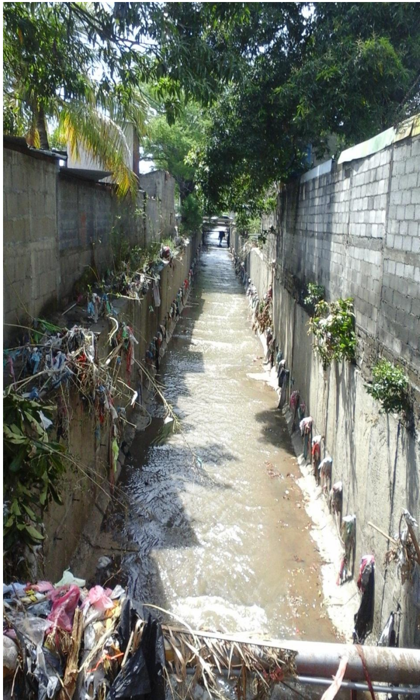
Foto 3 Ubicación de casas a orillas del cauce
