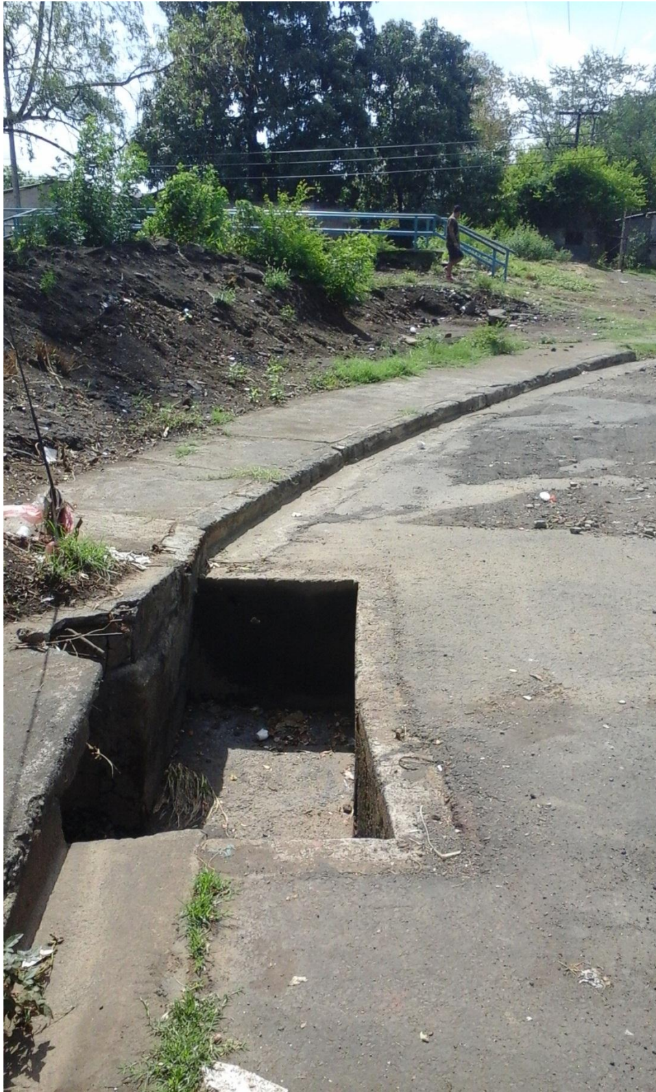
Foto 5 Tragante existente en calle al oeste del cauce
