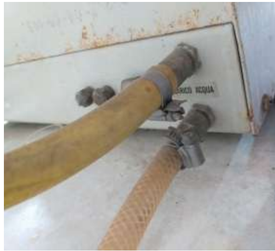
Fig. 6.1.3-1 Mangueras y Conexiones Dañadas
