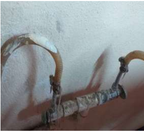
Fig. 6.1.3-1 Mangueras y Conexiones Dañadas
