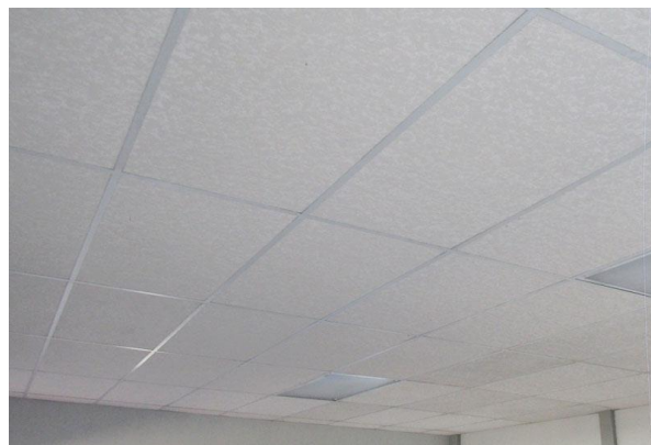
Ilustración N°29: Resultado final cielo falso
