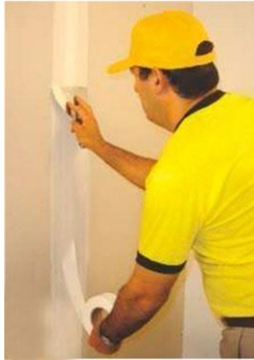
Ilustración N°24: Enmasillado.
