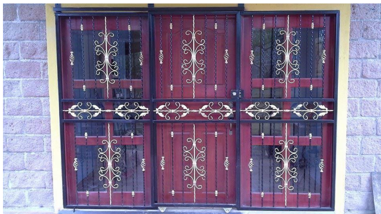
Ilustración N°59: Trabajo realizado - ´ puerta metálica
