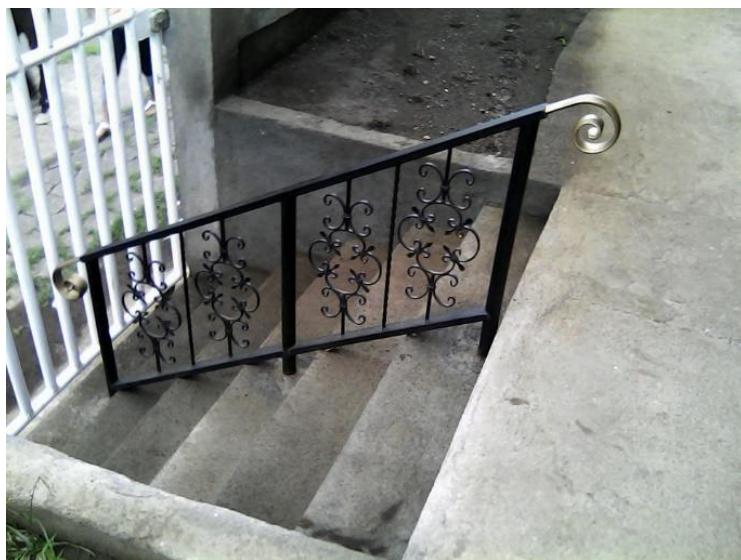
Ilustración N°57: Trabajo realizado -barandilla
