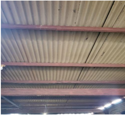
Figura 16: Techo de la empresa
