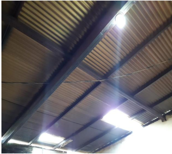
Figura 5: techo de la empresa
