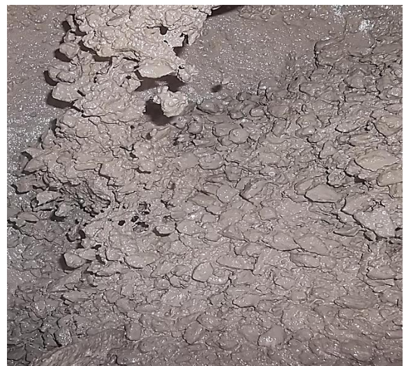
Fig. 9. Concreto recién mezclado. Imagen: Fuente propia.
