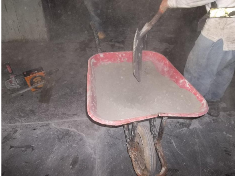
Imagen 10. Toma de muestra de concreto recién mezclado. Fotografía: Fuente propia.
