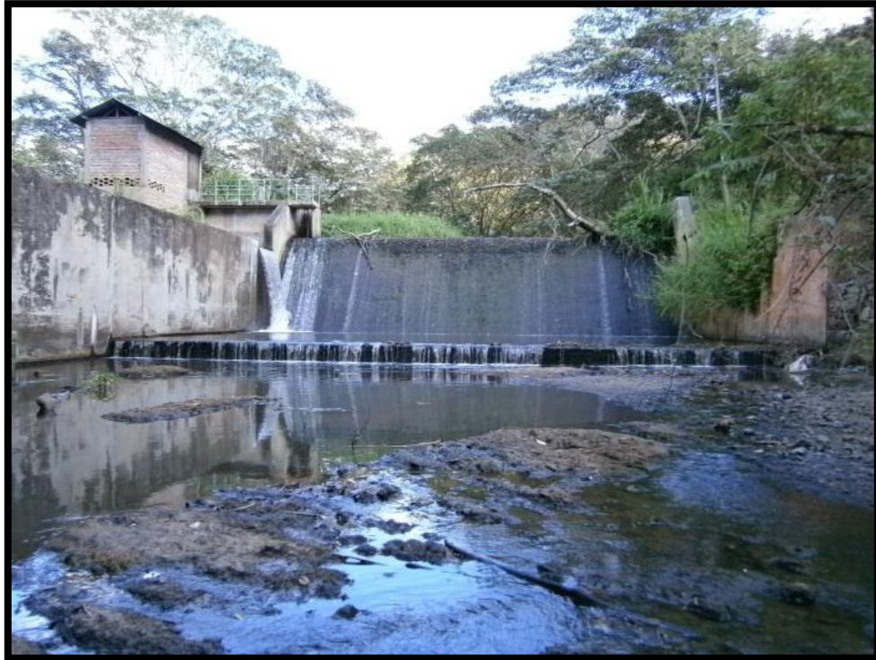
Fotografía Num.1 (Fachada frontal de Bocatoma, Punto de control)
