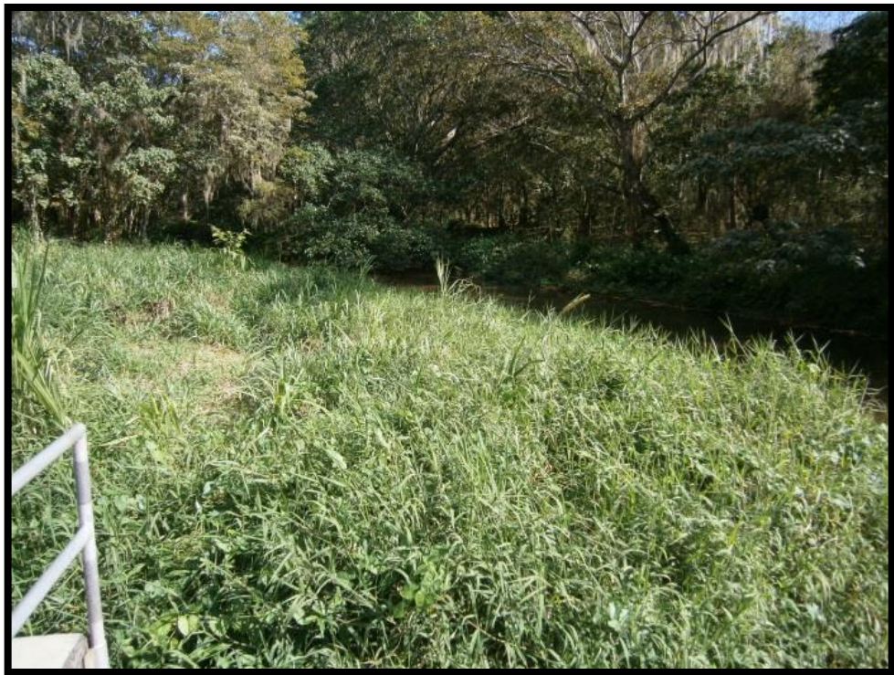
Fotografía Núm. 6 Acumulación de sedimentos en Presa San Francisco
