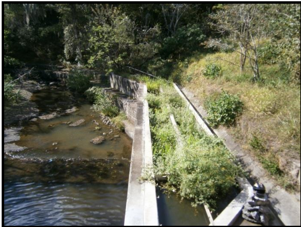
Fotografía Num.2 (Canal de desagüe)
