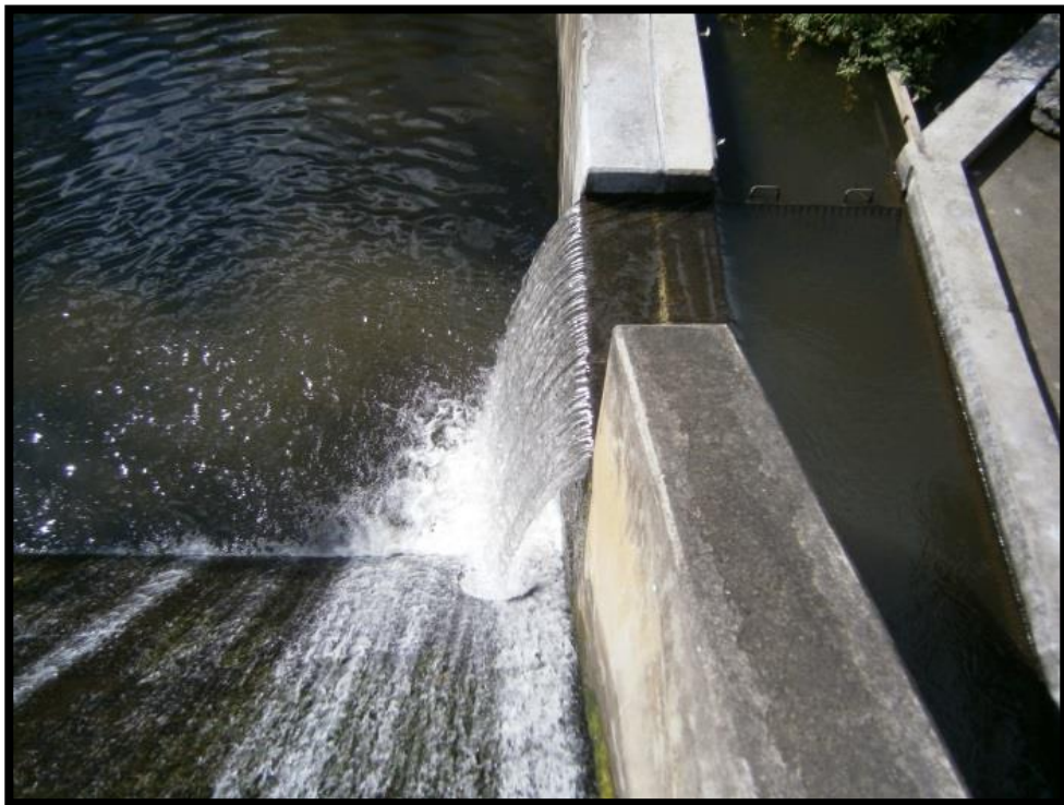
Fotografía Num.4 (Canal de desagüe)
