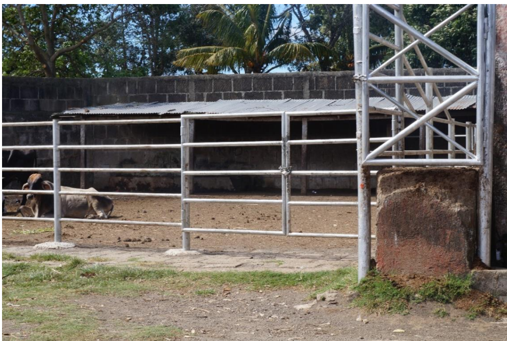
Foto N° A8. Condiciones de infraestructura de corrales.
