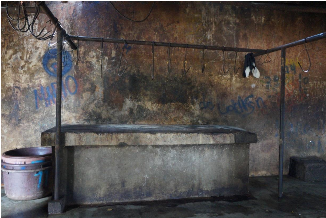
Foto N° A4 Mesa para destace y ganchos en área de destace de cerdos
