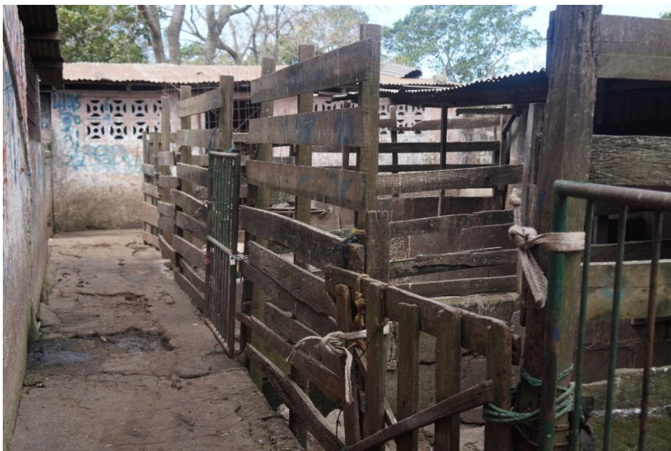
Foto N° A13. Pasillo en el área de corrales para cerdos.
