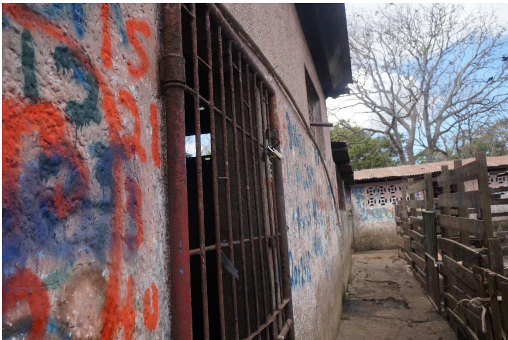
Foto N° A1. Pasillo que divide corrales de cerdos y área de destace de cerdos.
