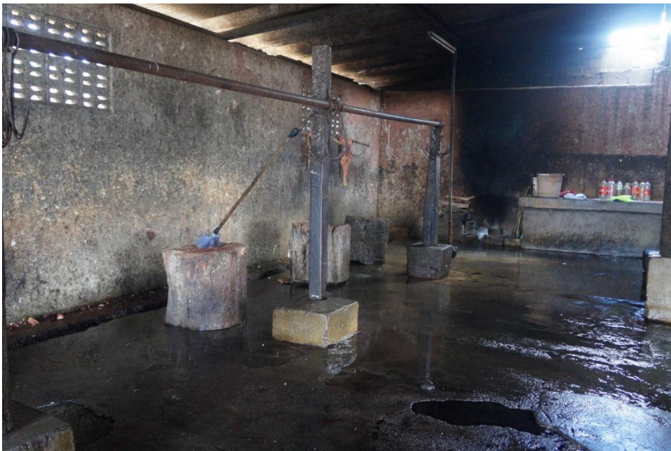
Foto N° A12. Condiciones de infraestructura en el área de destace de reses
