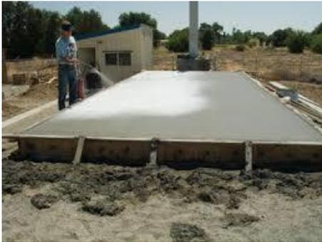
Con este método se consiguen buenos resultados y es fácil de ejecutar. Tiene el inconveniente de que la intermitencia o la aplicación ocasional, pueden conducir a un curado deficiente. El agua para curado del concreto debe estar libre de contaminantes y materiales deletéreos. En general se puede usar agua potable, que cumpla la norma de agua de amasado para concreto (ASTM C-59.
