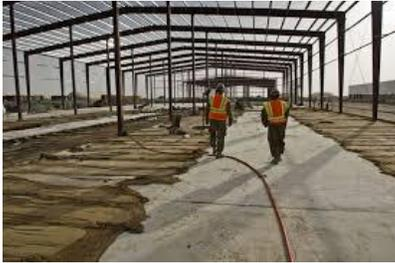
Se emplea con algún éxito el curado mediante el cubrimiento del concreto con alguno de los citados materiales; los dos primeros son muy útiles cuando se presentan vientos fuertes. Tienen, además de los inconvenientes de los tejidos de fique, el problema de que pueden manchar el concreto o deteriorarlo como sucede con el aserrín proveniente de maderas
