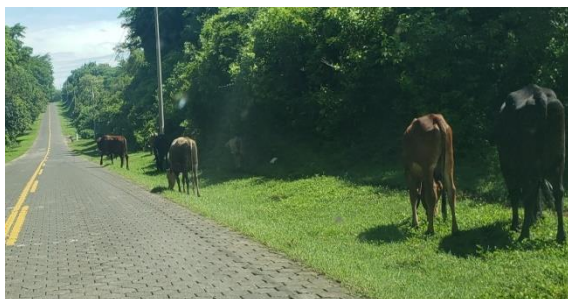
Figura 15: Semovientes en la vía, estación 56+000.
