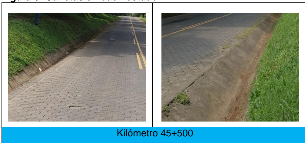
Figura 6: Cunetas en buen estado.
