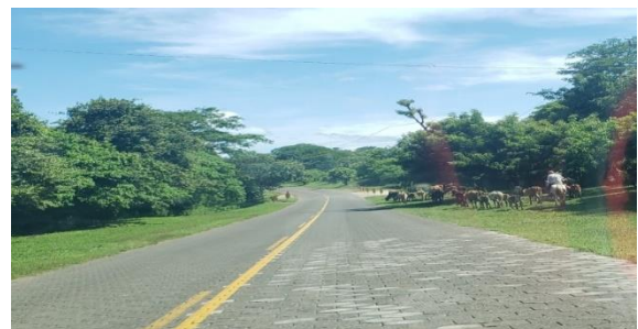
Figura 16: Semovientes en la vía, estación 57+000.
