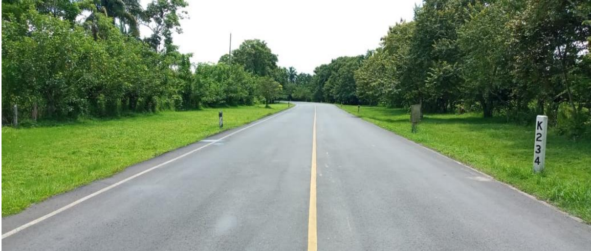
Figura N° 17. Tramo La Curva Nueva Guinea km 234, RACCS, carretera actual en excelentes condiciones.
