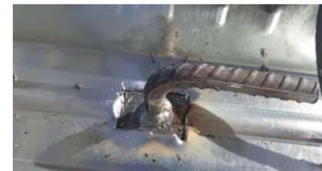
Pin para fijar la lamina troquelada.
