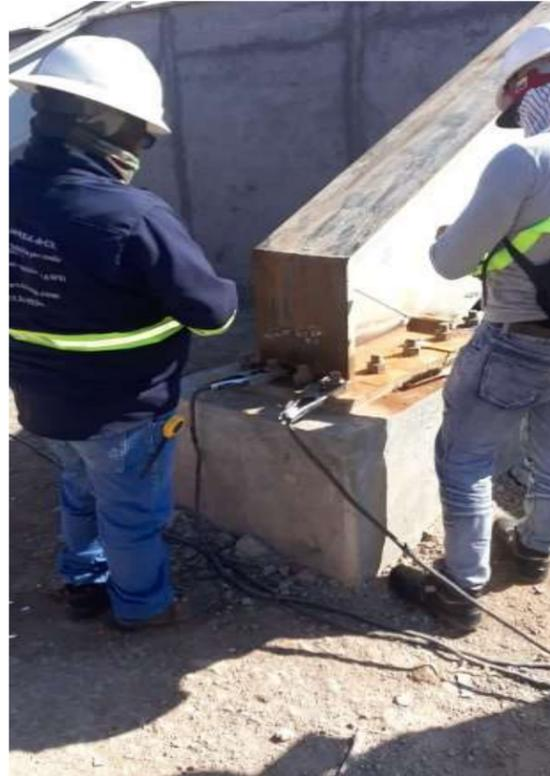
Supervisión IJS realizando verificación de espesores y marcando puntos para reparación.
