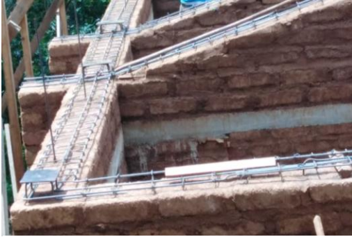
Imagen 25. Platinas para Techo en Viga Solera. Sabana Grande, Totogalpa.
