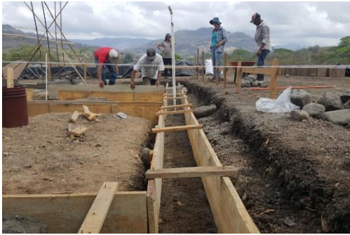
Imagen 67. Proceso de Construcción de Cimiento.
