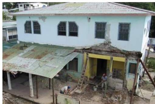
Imagen 88. Fachada Posterior de la Vivienda Antes de la Restauración.
