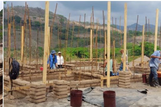
Imagen 77. Proceso de Levantamiento de Paredes de Adobes. San Dionisio, Matagalpa.
