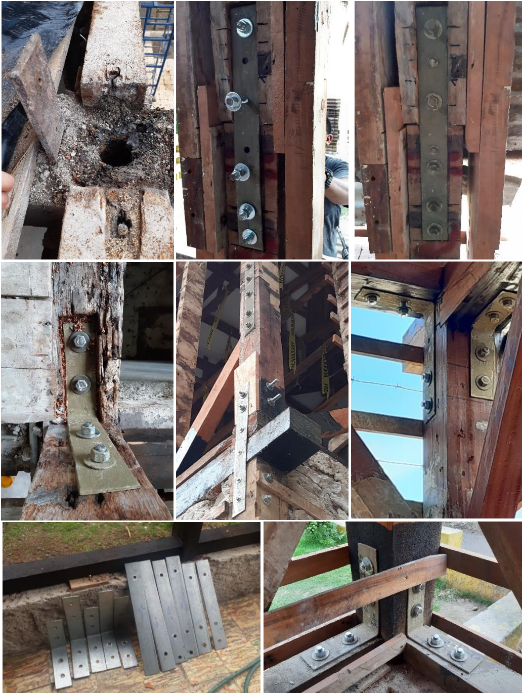
Imagen 102. Platinas Metálicas Colocadas en los Extremos de las Columnas
