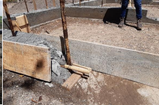
Imagen 68. Proceso de Construcción de Sobrecimiento.
