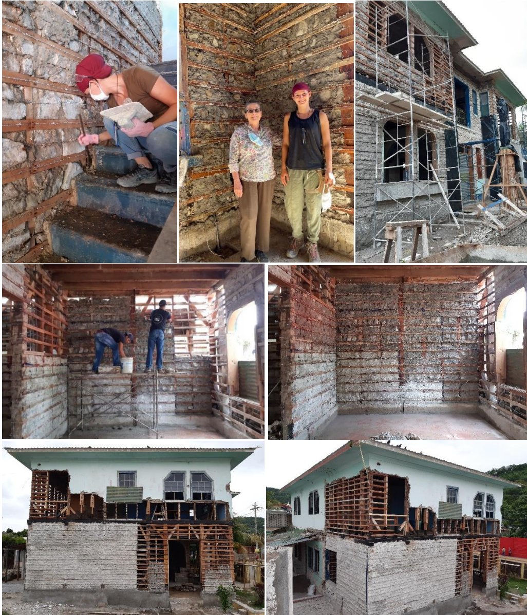
Imagen 106. Relleno de Paredes de Piedra Azul con Mortero de Cal y Arena.
