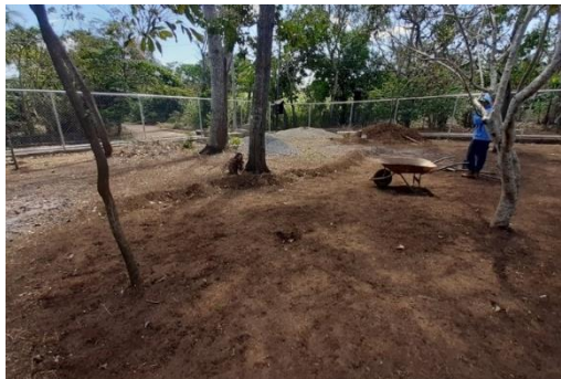
Imagen 33. Limpieza y Emparejamiento del Terreno.
