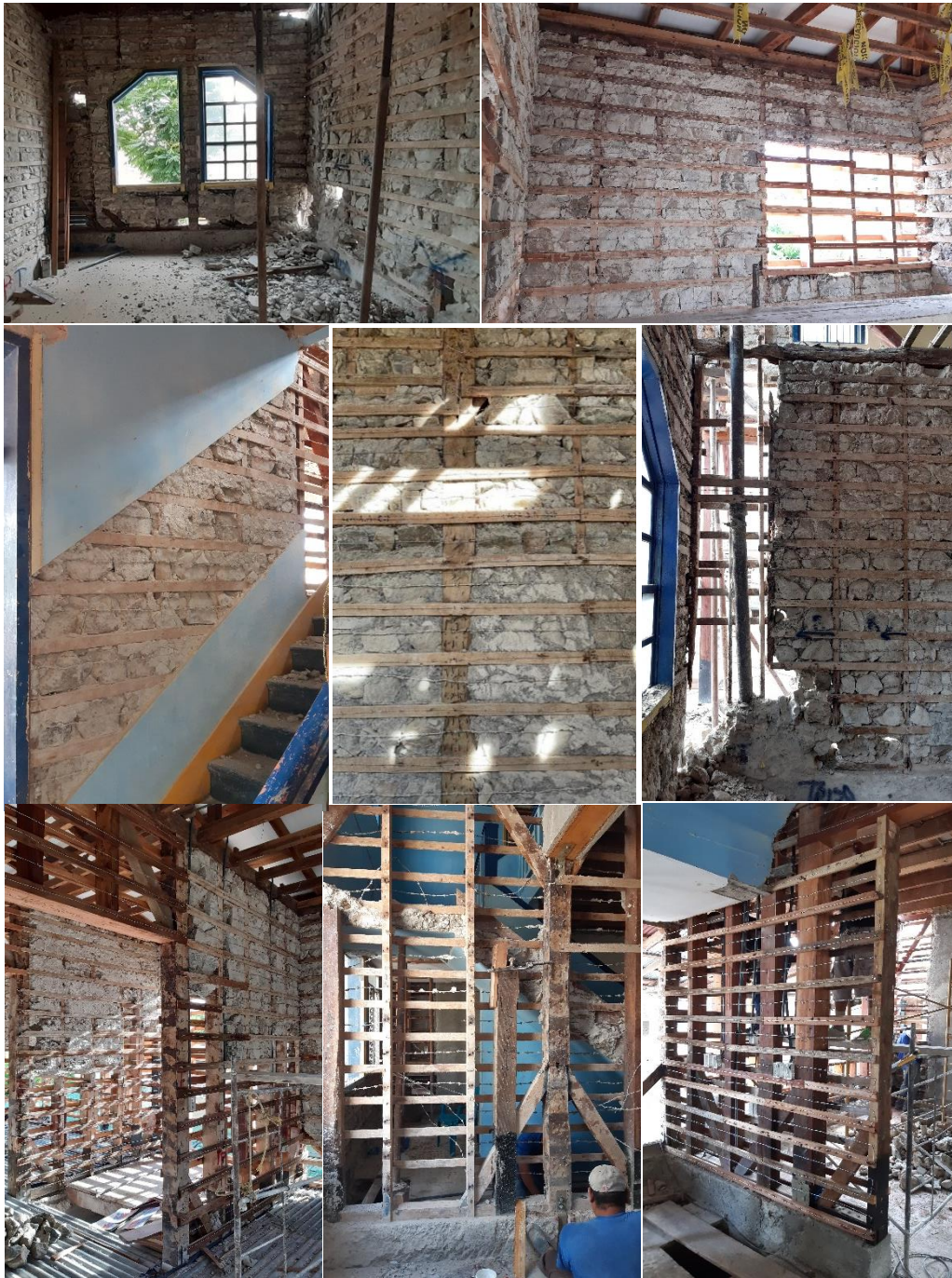
Imagen 104. Entramado o Esqueleto de Reglas de Madera.
