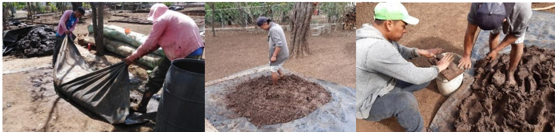
Imagen 15. Proceso de Agriado de Tierra de 24 horas.
