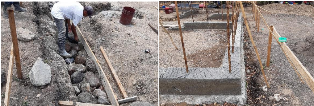
Imagen 18. Construcción de Cimiento Ciclópeo. San Dionisio, Matagalpa.
