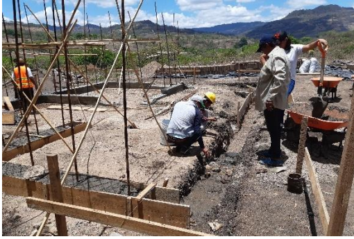
Imagen 71. Proceso de Construcción de Cimiento.
