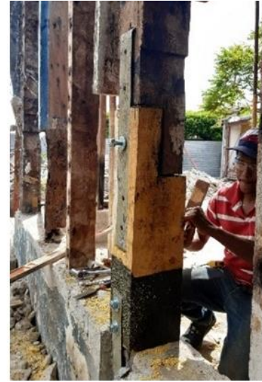
Imagen 92. Colocando Columna Nueva.
