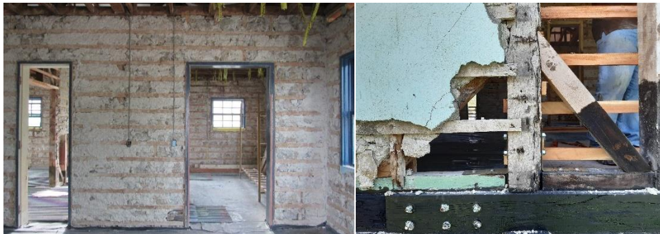
Imagen 27. Paredes Antiguas de Taquezal de Piedra Azul y Mortero de Cal con Arena.
