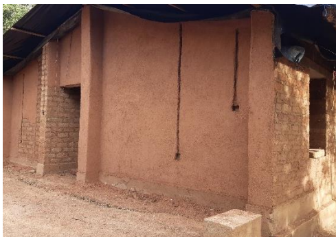
Imagen 20. Pared con Contrafuertes. Sabana Grande, Totagalpa.
