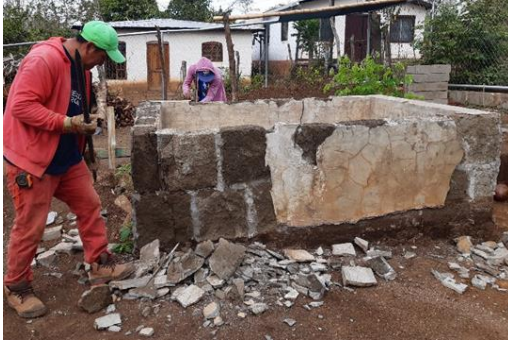
Imagen 49. Demolición de Pila de Agua Antigua.
