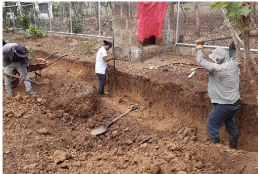
Imagen 37. Iniciando Corte del Terreno.
