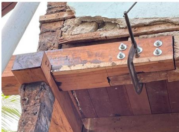
Imagen 93. Prótesis de Vigas Intermedia y Viga Intermedia Pintada con Alquitrán.
