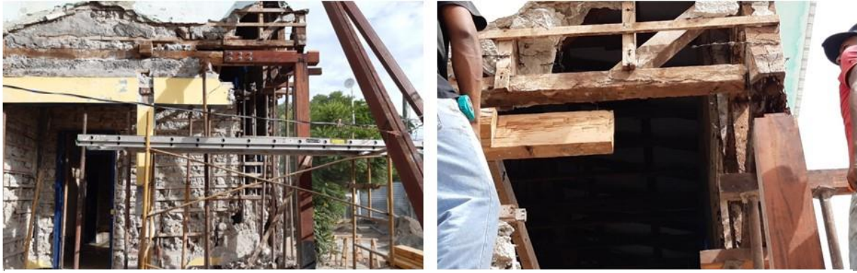
Imagen 94. Prótesis de Vigas Intermedias.
