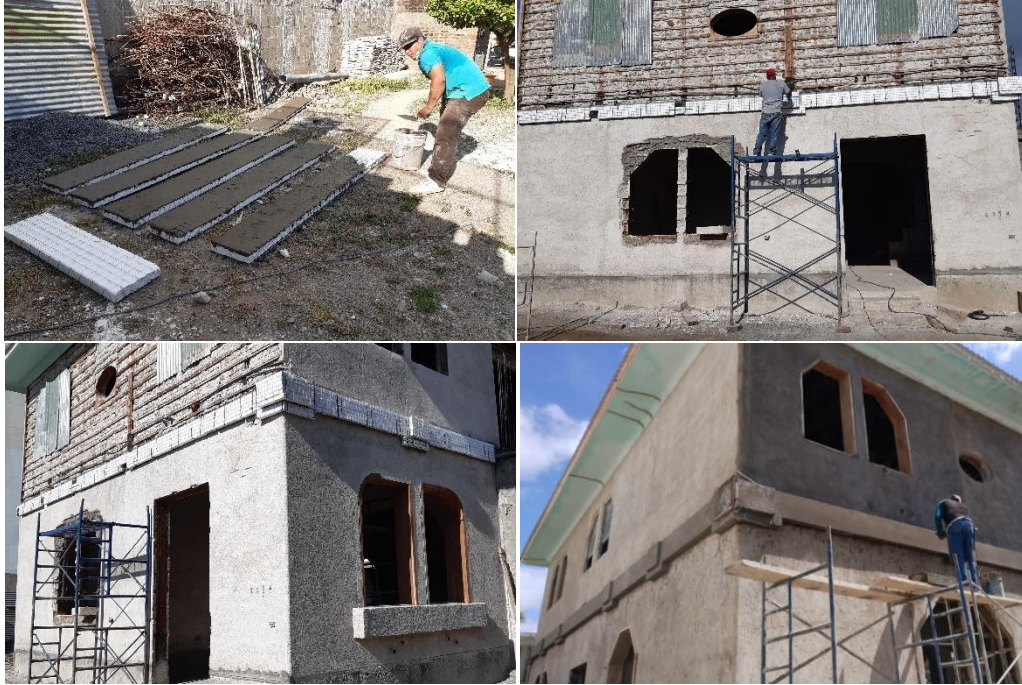
Imagen 115. Proceso de Reconstrucción del Friso.
