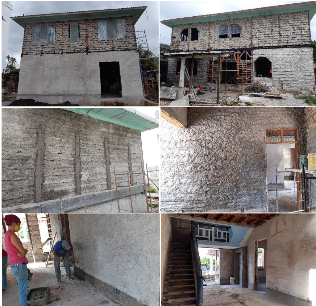
Imagen 109. Proceso de Repello de Paredes.
