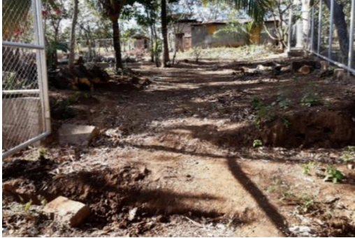
Imagen 29. Entrada al Sitio de Construcción.
