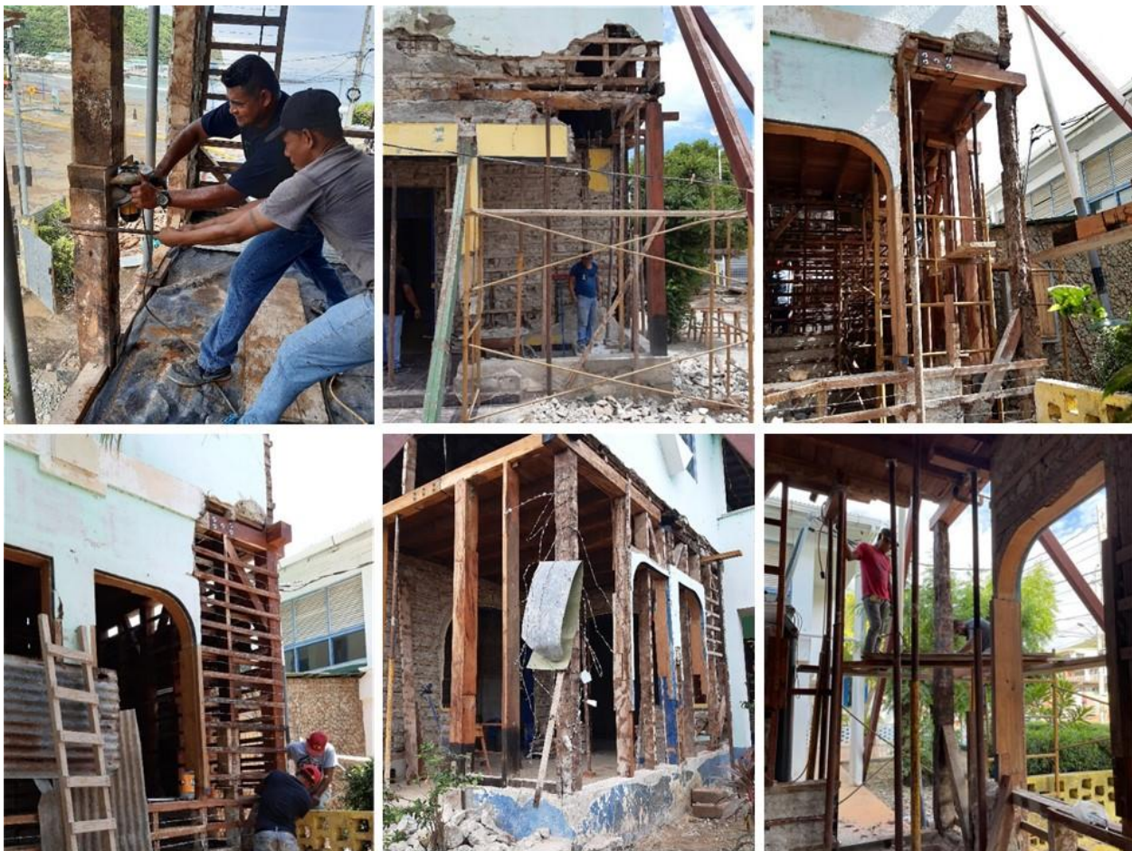
Imagen 89. Reemplazando Columnas Antiguas en Mal Estado. Casa Museo San Juan del Sur.
