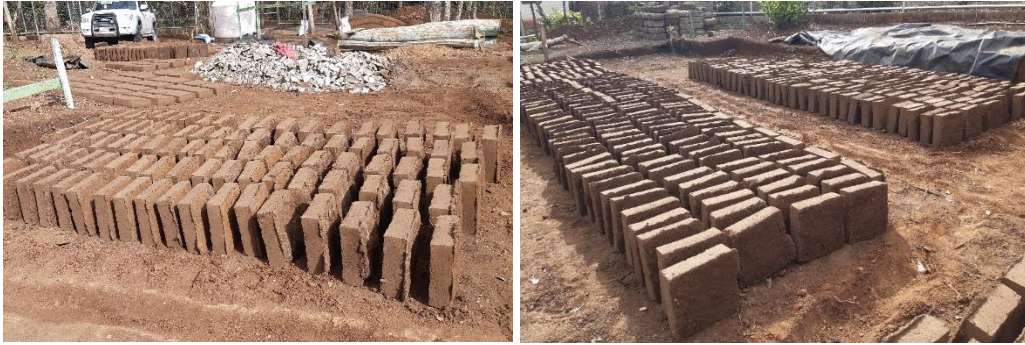
Imagen 64. Adobes Colocados de Canto para un Secado Rápido y Completo.
