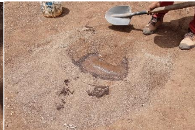
Imagen 14. Preparando Mezcla de Tierra para Adobes.
