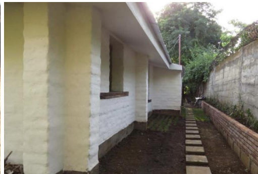
Imagen 21. Paredes Exteriores con Contrafuertes. Managua. Fuente: DMG
