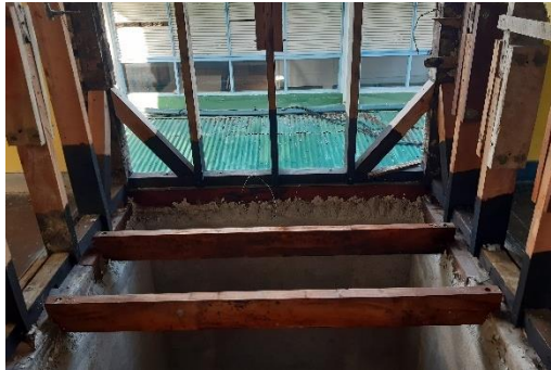
Imagen 98. Entrepiso de Madera en Baño.
