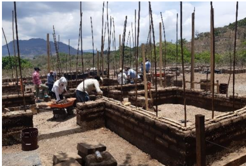
Imagen 77. Proceso de Levantamiento de Paredes de Adobes. San Dionisio, Matagalpa.
