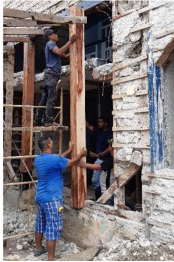
Imagen 91. Prótesis de Columna.
