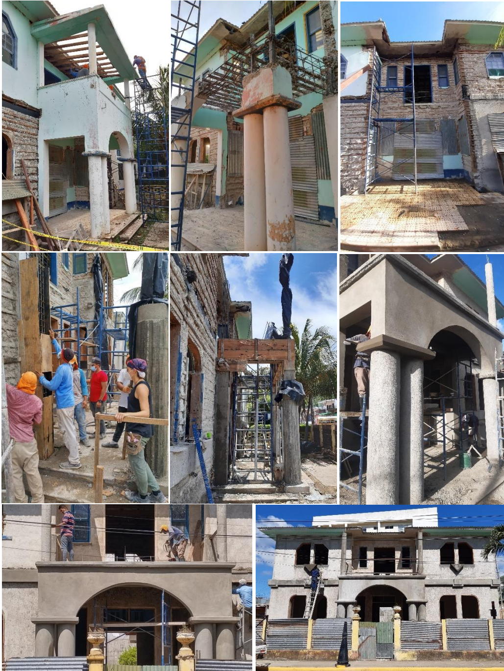
Imagen 114. Proceso de Reconstrucción del Porche.
