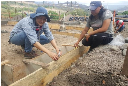
Imagen 69. Marcando las Distancia para la Colocacion de las Cañas de Castilla.
