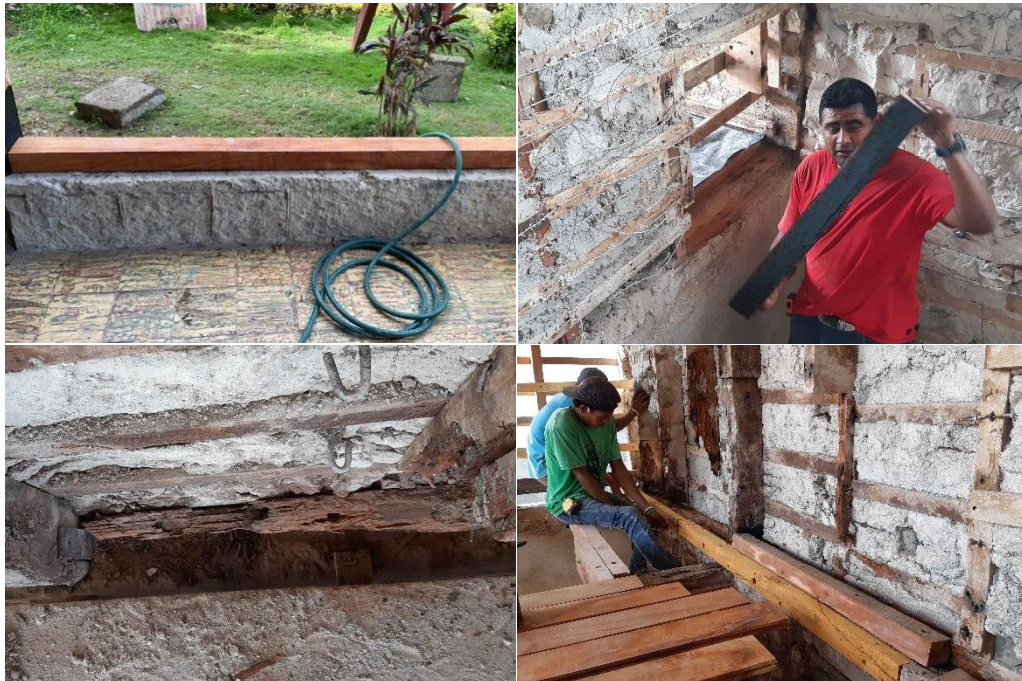
Imagen 101. Reemplazo de Vigas Muerto.
