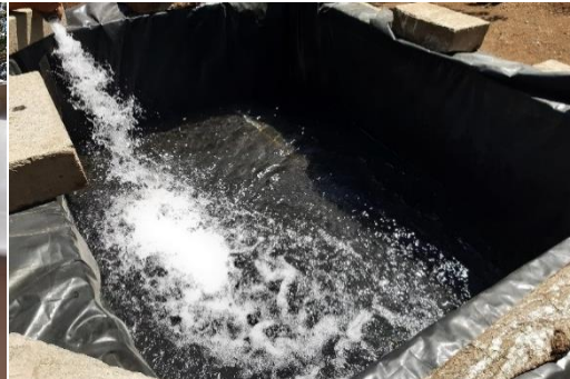
Imagen 48. Rellenando de Agua la Pila Temporal.
