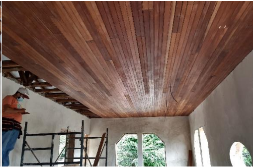
Imagen 120. Restauración del Cielo Raso de Madera.
