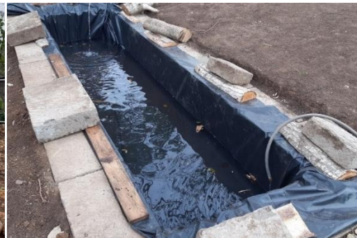
Imagen 32. Construcción de Pila de Agua Temporal.
