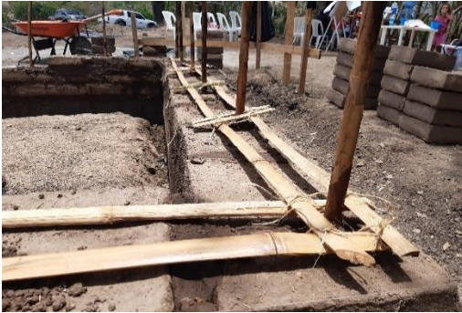
Imagen 75. Refuerzo Horizontal de 1/2" caña, a cada 3 hiladas.
