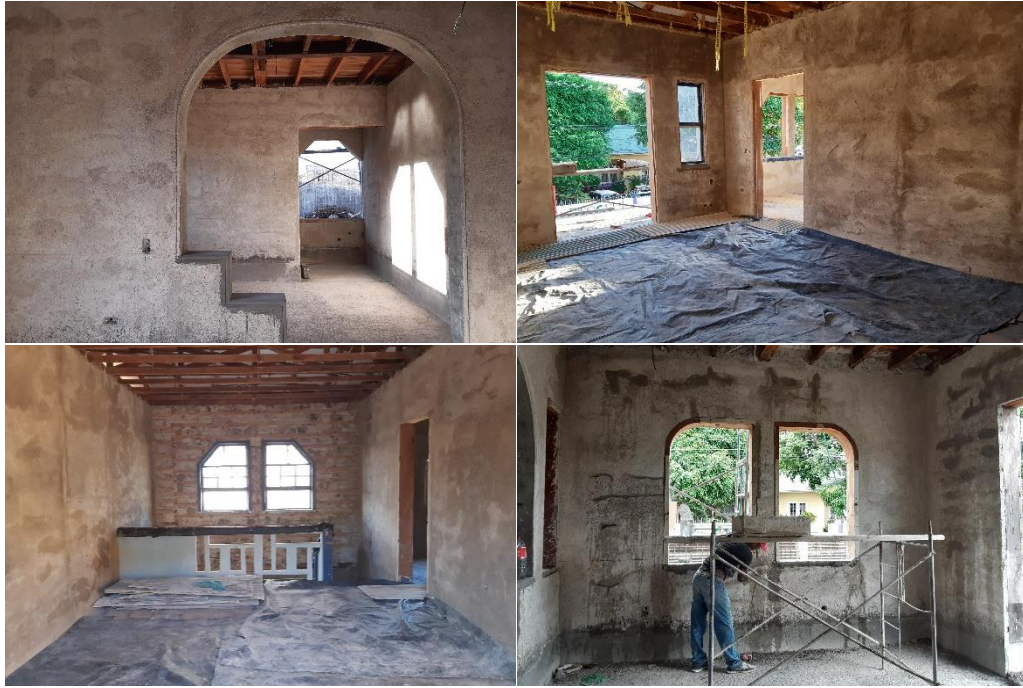
Imagen 110. Paredes con Repellos de Cal y Arena.
