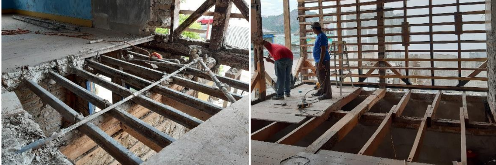
Imagen 96. Reemplazando Rieles de Tren por Vigas de Madera.
