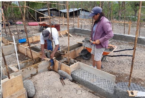
Imagen 74. Construcción del Sobrecimiento.
