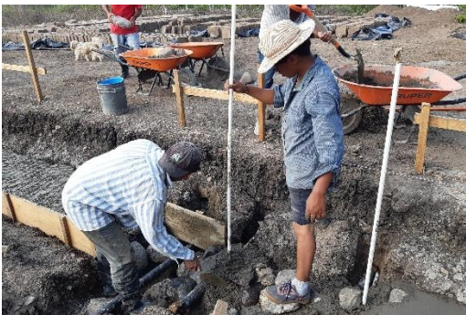
Imagen 73. Colocando Esperas de Tuberías en Sobrecimiento.
