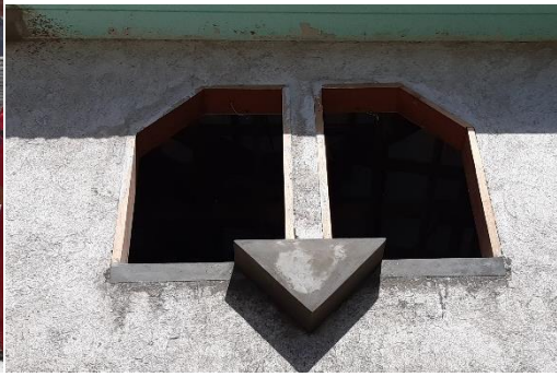
Imagen 117. Reconstrucción de Triángulos Decorativos en Fachada Principal.
