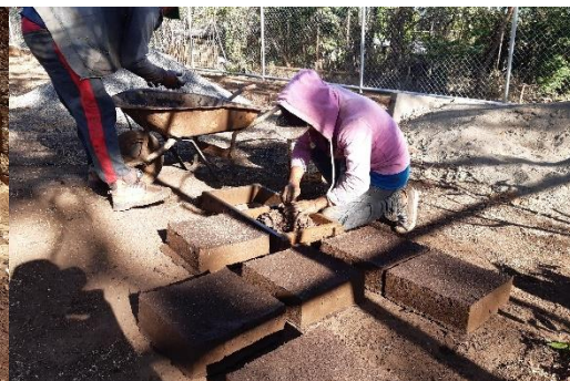
Imagen 59. Los Primeros Adobes Mejorados con la Dosificación Correcta.
