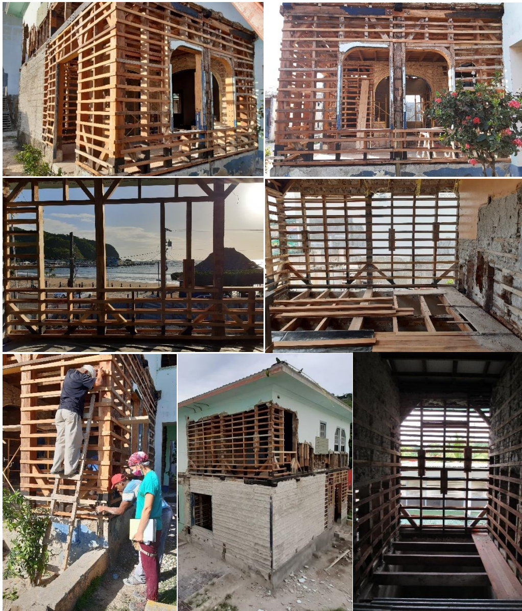
Imagen 105. Entramado Nuevo de Reglas Madera.
