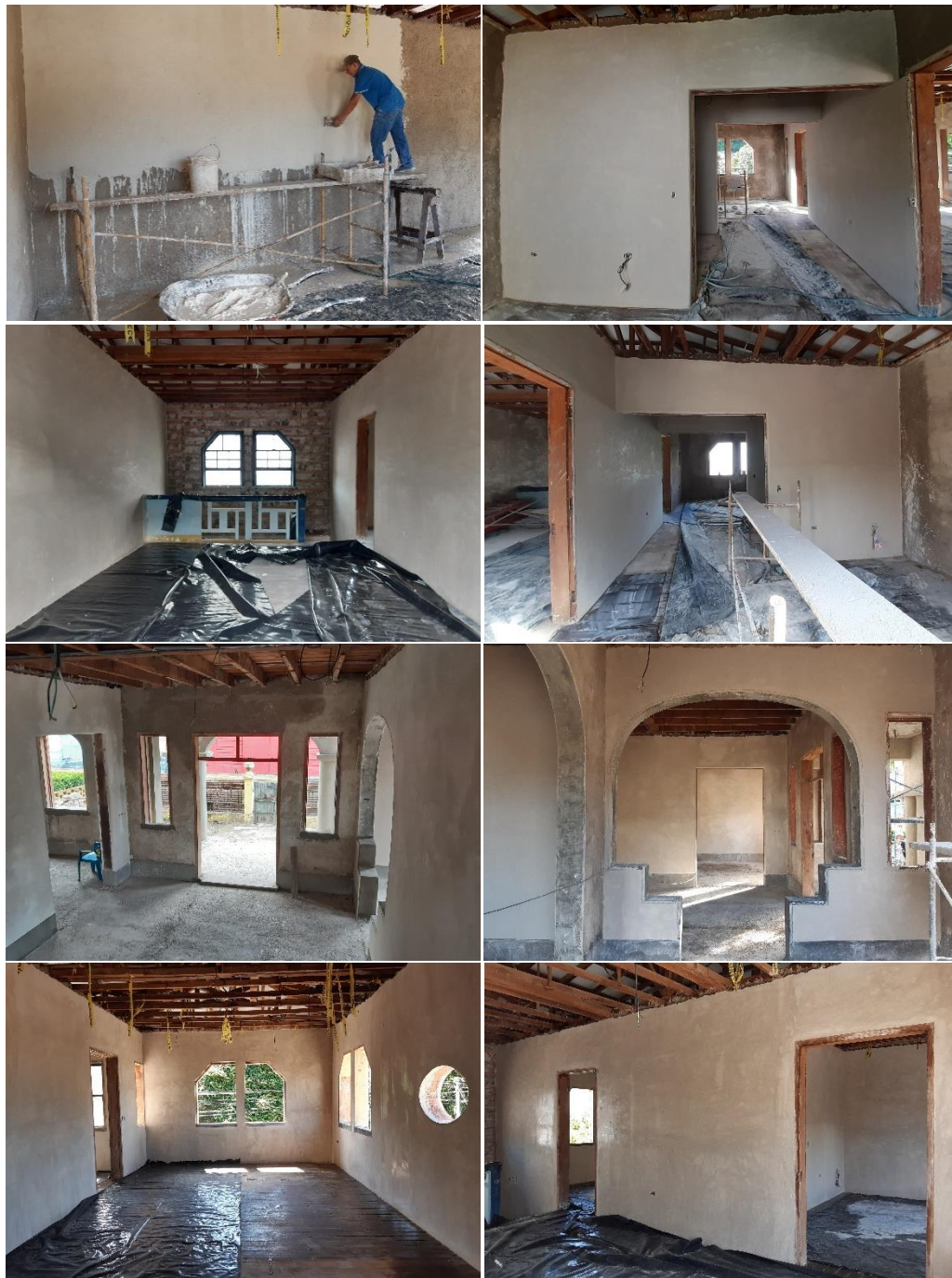
Imagen 113. Fino de Cal en Paredes Interiores
