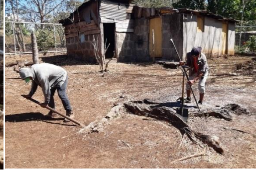
Imagen 30. Limpieza de Raíces en Área a Construir.
