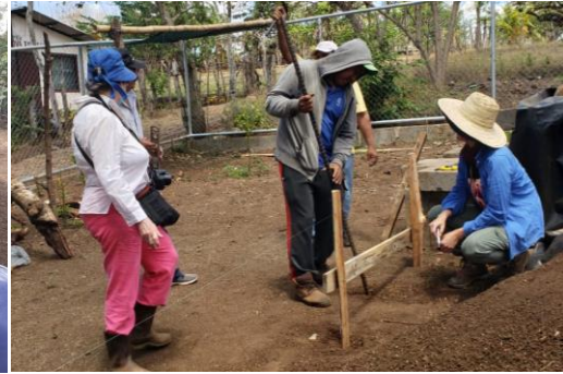
Imagen 36. Rectificando Niveles con la Arq. Asesora.
