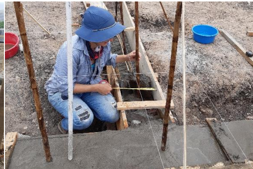
Imagen 70. Refuerzo Vertical de Caña de Castilla en Sobrecimiento
