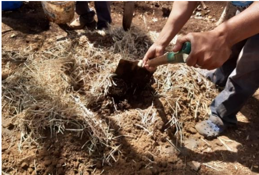
Imagen 57. Mezclando Materiales en Seco.
