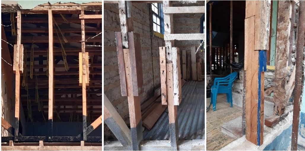
Imagen 100. Reemplazo de Parales Antiguos y Realización de Prótesis.
