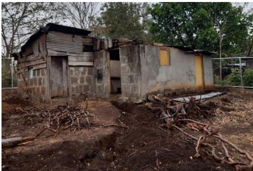
Imagen 31. Reparación de Techo de bodega.
