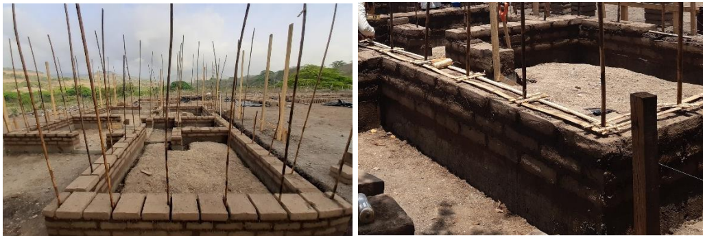
Imagen 22. Refuerzos Verticales de Caña de Castilla. Imagen 23. Refuerzo Horizontal de \frac{1}{2} Caña de Castilla.
