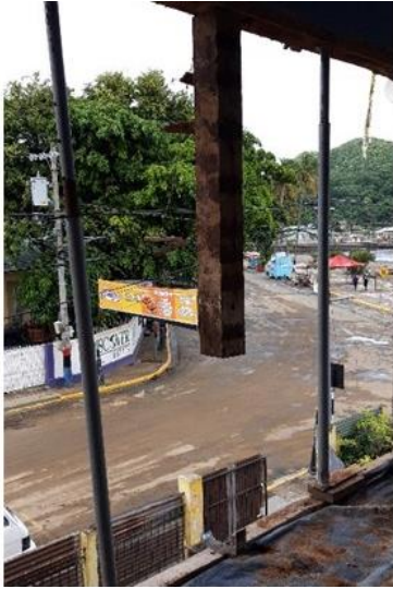
Imagen 90. Columna Antigua Esperando Prótesis de Base.
