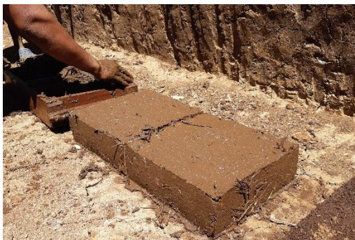
Imagen 59. Los Primeros Adobes Mejorados con la Dosificación Correcta.
