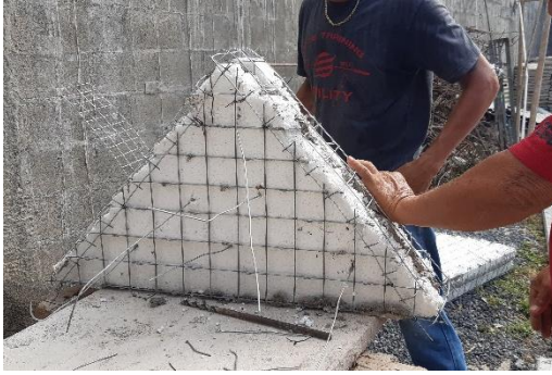
Imagen 117. Reconstrucción de Triángulos Decorativos en Fachada Principal.
