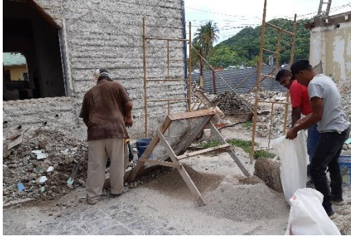
Imagen 107. Colando el Relleno Antiguo de las Paredes para Reusar la Arena y Cal del Mortero.
