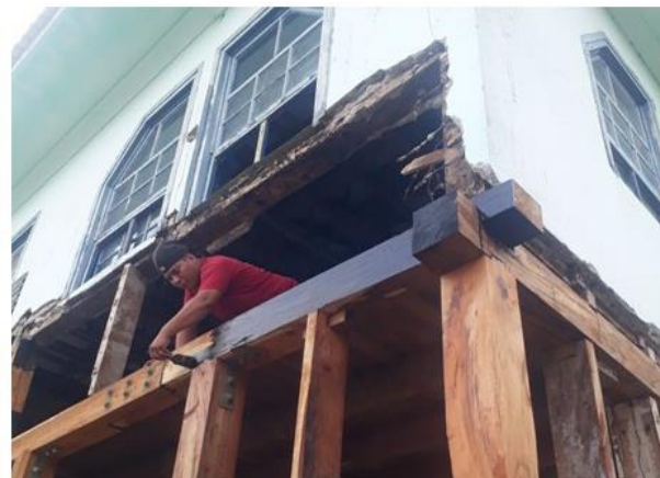
Imagen 93. Prótesis de Vigas Intermedia y Viga Intermedia Pintada con Alquitrán.
