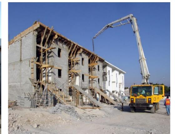
**Ilustración 29** Proceso de edificación por medios mecánicos. Fuente: <http://www.imcyc.com/revistacyt/dic10/vivienda.htm>
