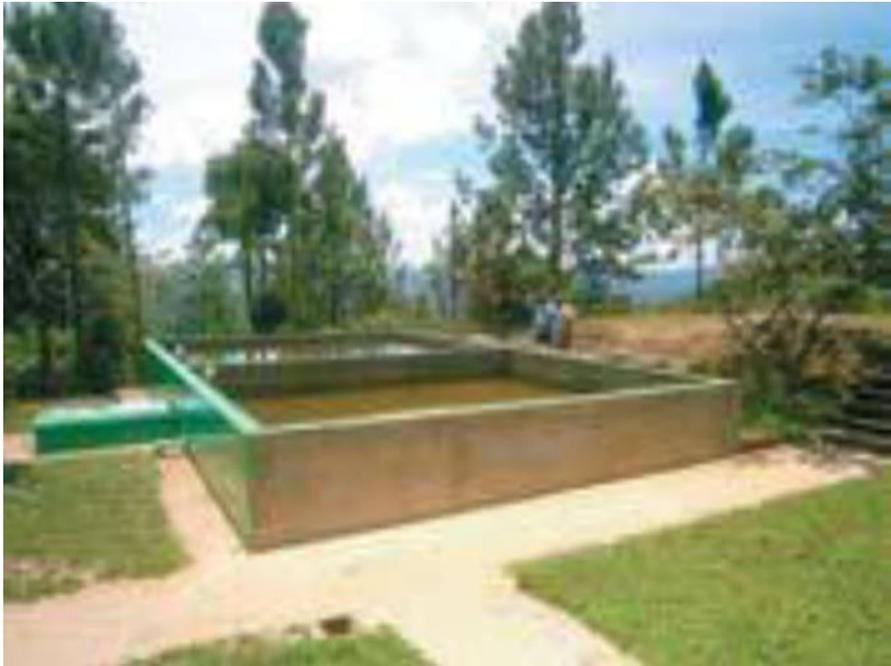
**Figura 3.5: Filtro grueso ascendente en capas (FGAC).**
