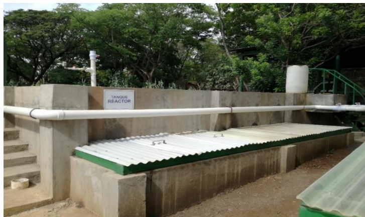
Figura 4.8: Reactor tipo FAFA.
