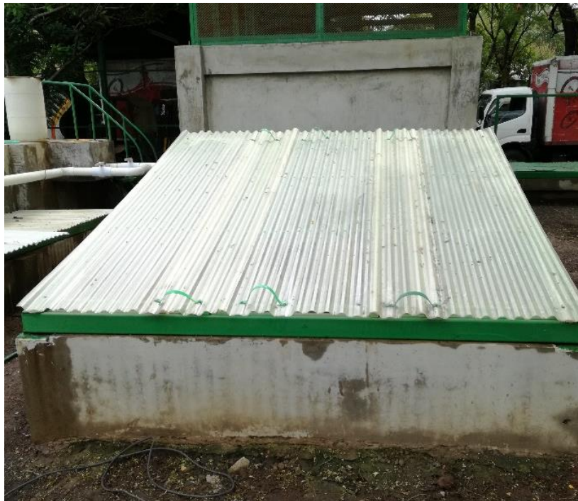
Figura 4.18: Pila de secado de lodos.
