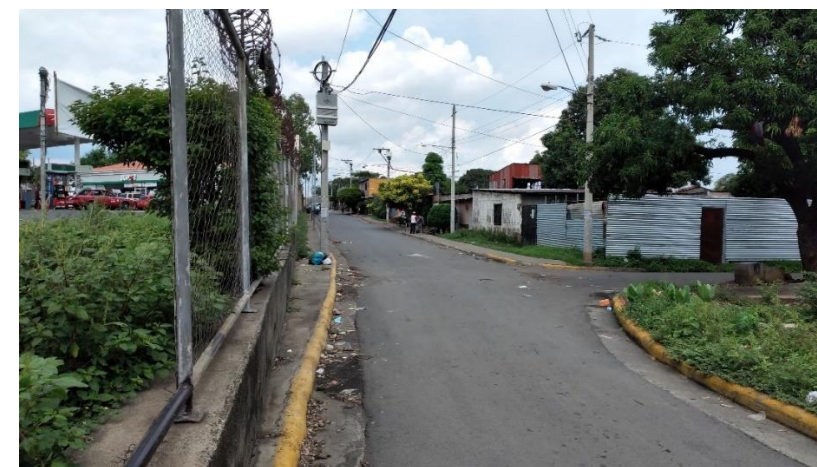
Ilustración 37-Estado actual de las vías del barrio Enrique Smith 1, Fuente: Guillen R.; Gómez, C. y Mercado, M. (2022)
